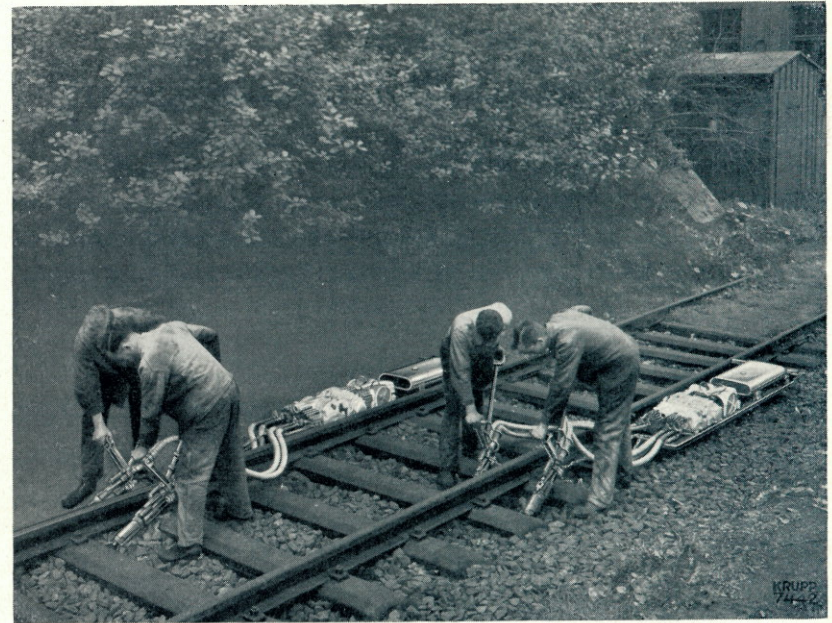
Bild 1. Gleisstopfmaschinen bei der Arbeit.
