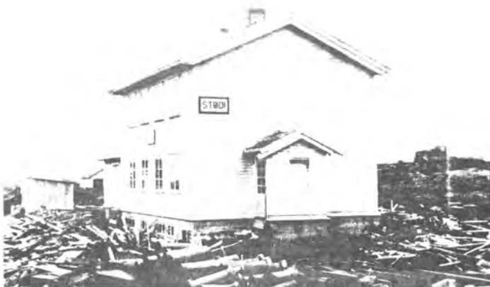
Foto nr. 79. Stødi st. (Under oppførelse) Banens høyeste st. 680 m.o.h. Rana kommune
