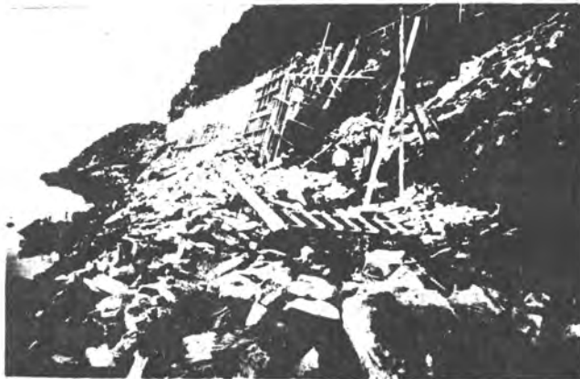
Foto nr. 44. Støttemur under Kvenflåget, tnl. syd.
