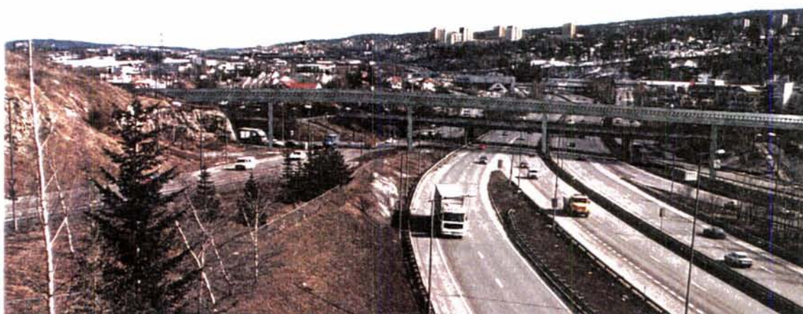
Utsikt fra veikanten sett mot øst og eksisterende jernbanebru over E6. Eksisterende situasjon og situasjonen i alternativ N1 og N4 etter utbygging.
