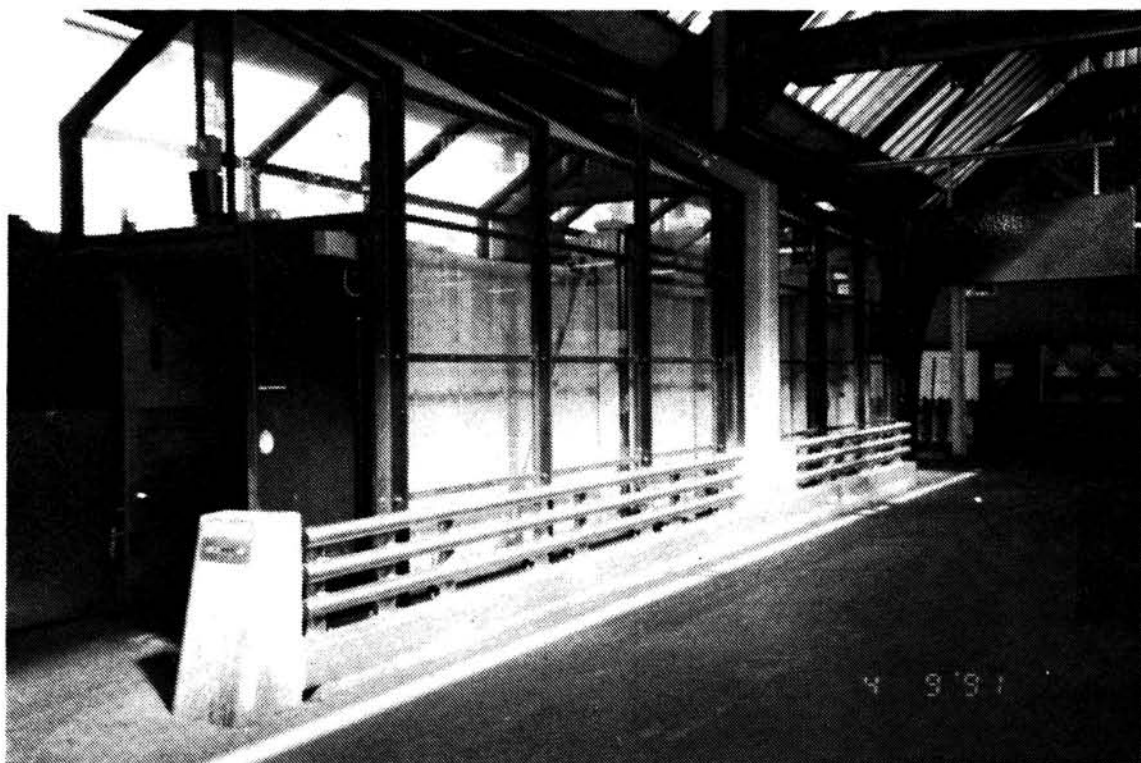
Bilde 3: Ved enden av hver plattform var det heiser for frakting av traktor m/vogner opp på plattformen. I bakkant av heisen kan byggeplass for nytt innsjekkingsområde skimtes.
