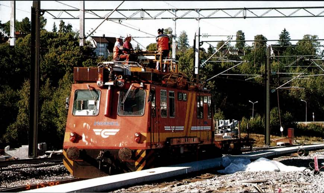
Kontaktledningsmastene er på plass mange steder. Her montering av åk på Lillestrøm. Foto NSB-GMB
