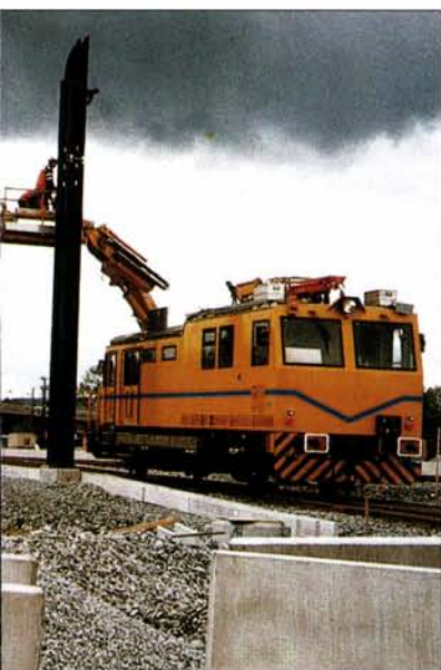
Kontaktledningsmaster monteres. Foto: NSB-GMB
