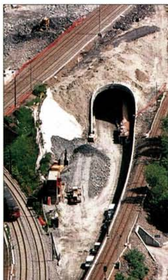
Inngangen til Romeriksporten på Etterstad, 24.6.1996/Scanfoto
