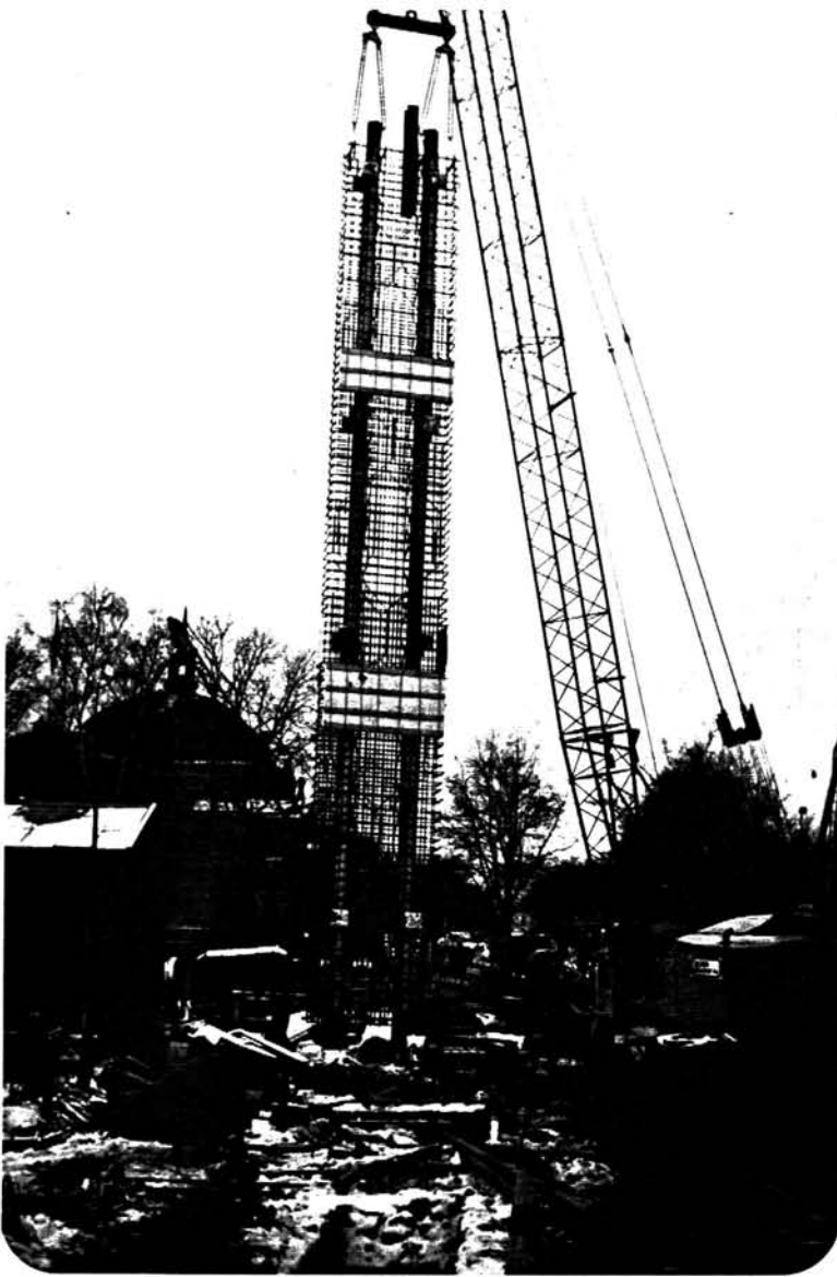
Armeringskurv under nedfiring i en slisseveggseksjon, som har en bredde på 1m og lengde på 5m. Armeringskurvens høyde er 22m.
