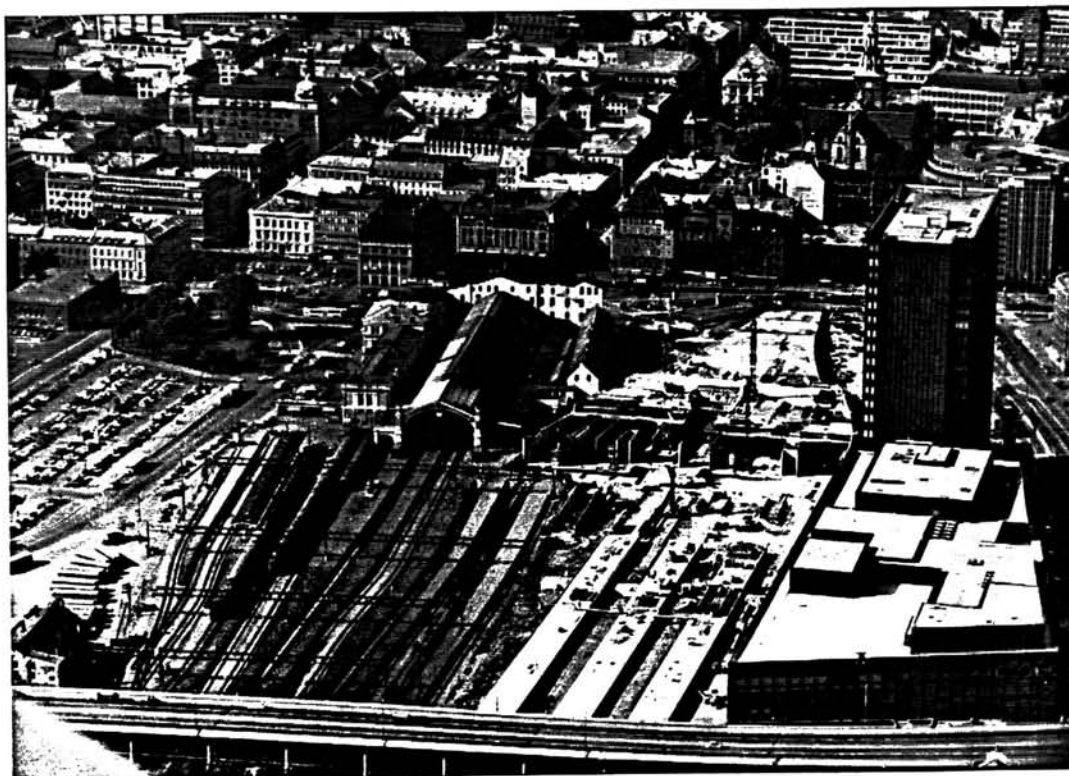
Situasjonen i 1977. Til venstre den gamle stasjonsbygning og toghall. Til høyre innkjøringen til Oslo-tunnelen. På tunneltaket er byggingen av den nye stasjonsbygning såvidt begynt.
