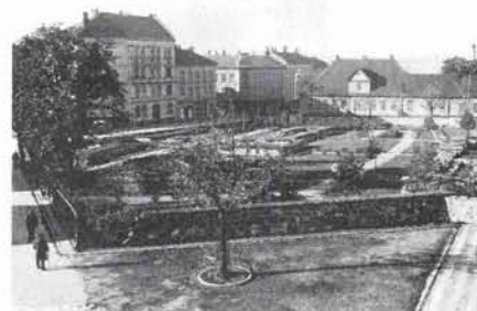
Illustrasjon 2.7.4 Ruinparken med Hallvards katedralen i 1932, sett fra øst. Østfoldbanen går i kulvert under de vestre delene av kirken, og disse er rekonstruert oppå kulverttaket.
