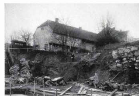
Illustrasjon 2.7.10 Fra utgravings- / anleggsarbeid i 1917. G. Fisher midt på bildet, Ladegården bak.
