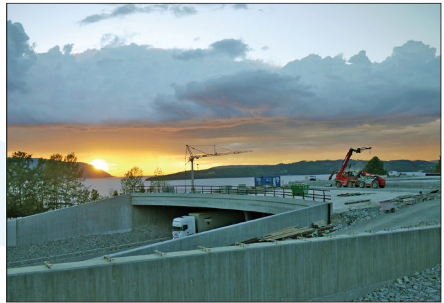
Kveldssol over betonglokket ved Bolleland på Espa. Snart starter arbeidet med ramper ned til E6 på østsiden. (Foto: Olav Nordli)
