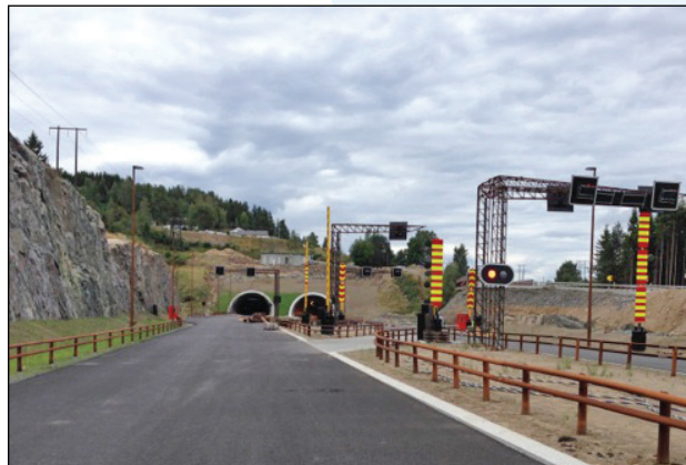
Snart vil all trafikk på E6 bli ledet gjennom det nordgående tunneløpet. (Foto: Terje Holtekjølen)
