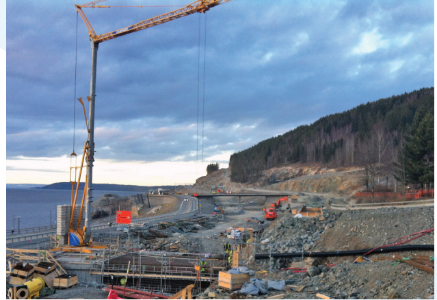
Den nye motorvegen tar form på Strandlykkja. (Foto: Ole Tom Dokken)
