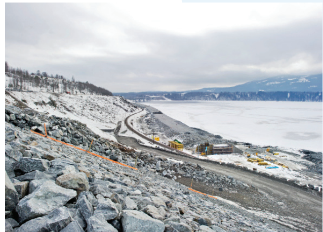
Arbeidene med utfylling av stein for nytt dobbeltspor er godt i gang.
