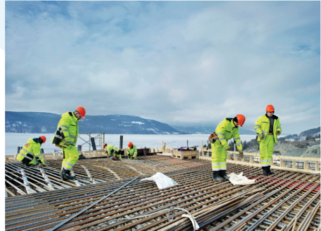
Støping av ny bru over E6 ved Langset.
