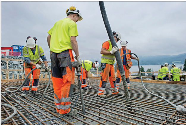
Den 5. august ble kulverten under E6 på Ørbekk støpt i en sammenhengende økt på drøye 12 timer. Omtrent 420 kubikk med betong gikk med i støpen. Fra begynnelsen av september vil trafikken legges over den nye kulverten. (Foto: Hilde Lillejord)
