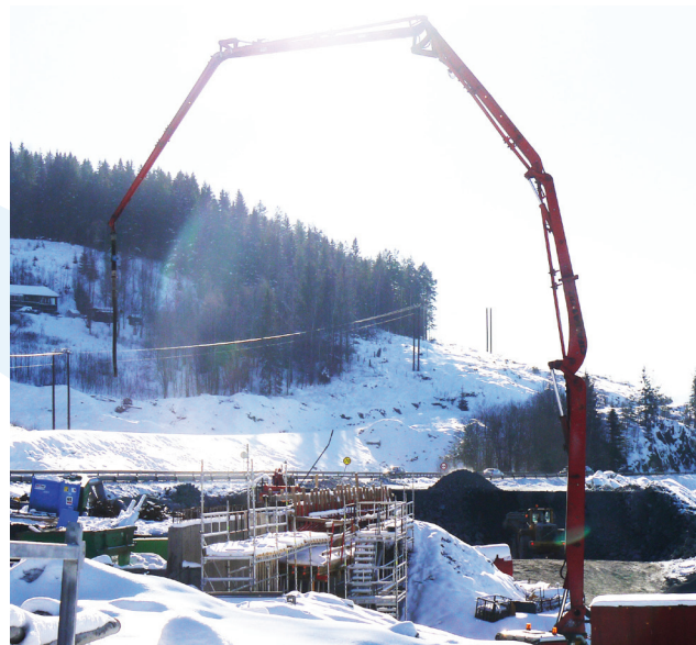
Støping av dekke på Brøhaug kulvert.
