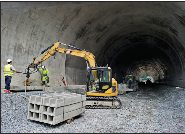
Legging av kabelkanaler gjennom Morstuatunnelen. (Foto: Hilde Lillejord)
