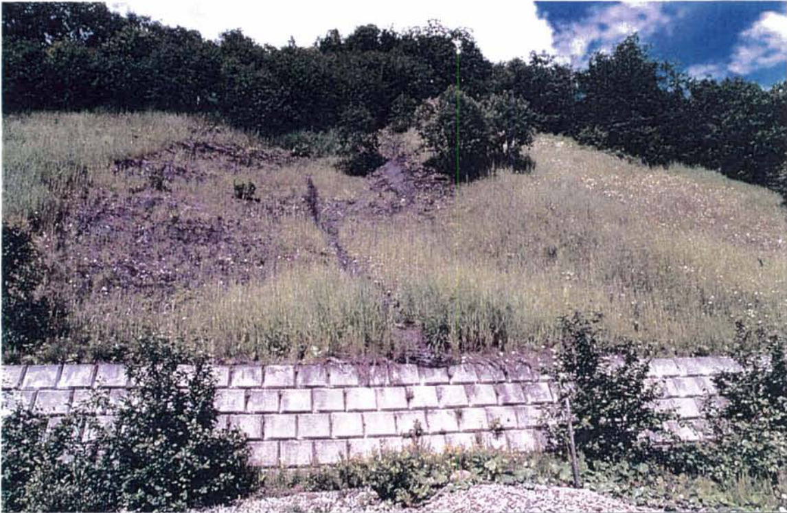
Bilde 4: km 490,32. Skjæring sikret med armeringsnett 1991.
