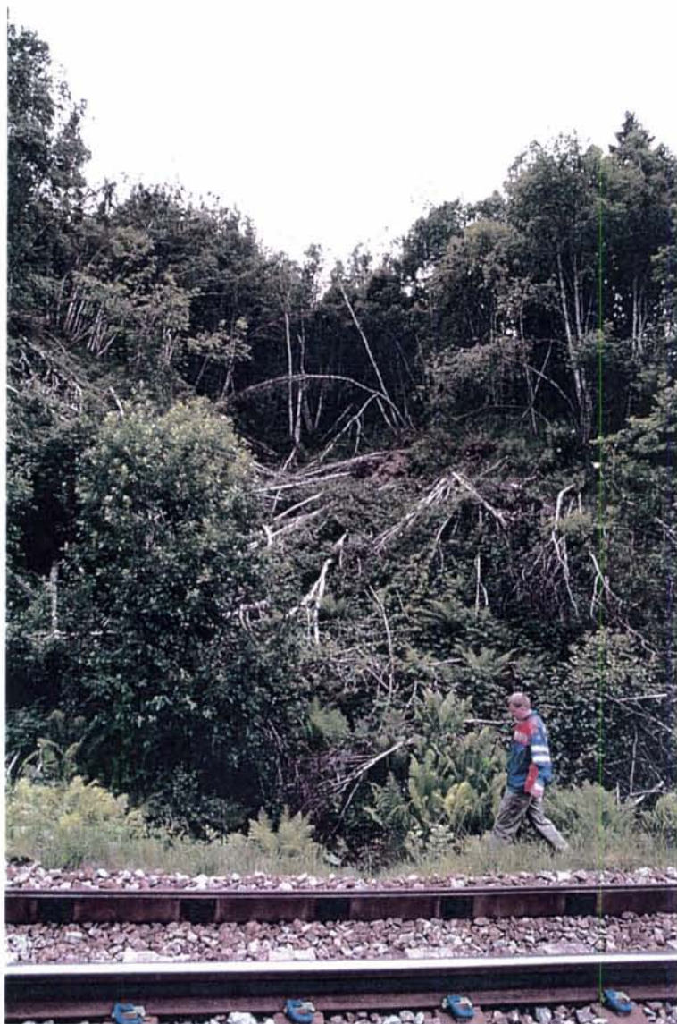
Bilde 7: km 495,82. Bekkedal der mange trær har veltet pga. tung snølast siste vinter. Fare for igjentetting av stikkrenna.
