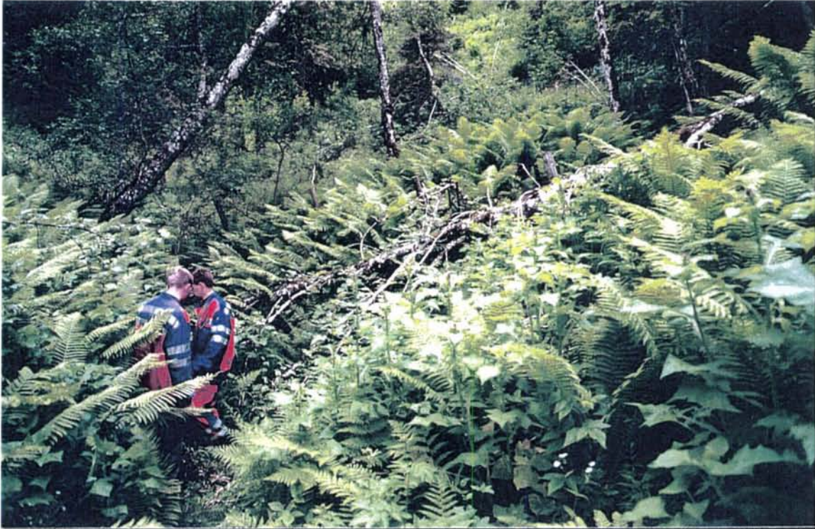
Bilde 6: km 495,58. Personene står ved innløpet til en stikkrenne. Her burde eksisterende grøfter lokaliseres og renskes.
