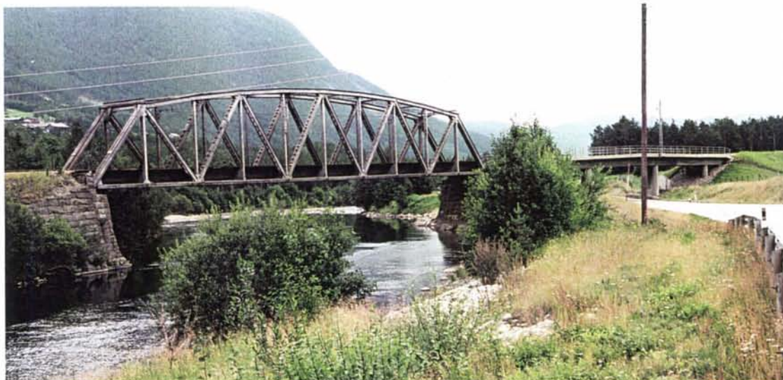
Foto 129: Den klassiske fagverksbrua over Lågen ved Tallerås tapte mye av sin glans da brua over ny E6 ble bygd helt inntil den gamle brua uten tanke på sammenbinding i et felles formspråk.
