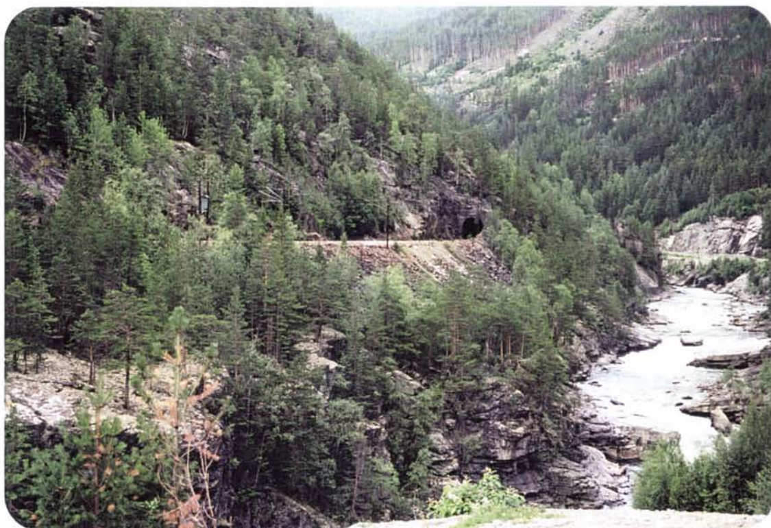
Foto 122: Gjennom Rosten er jernbanen lagt på utsprengte hyller og fyllinger oppe i vestre dalside. Strekningen har 3 mindre tunneler.
