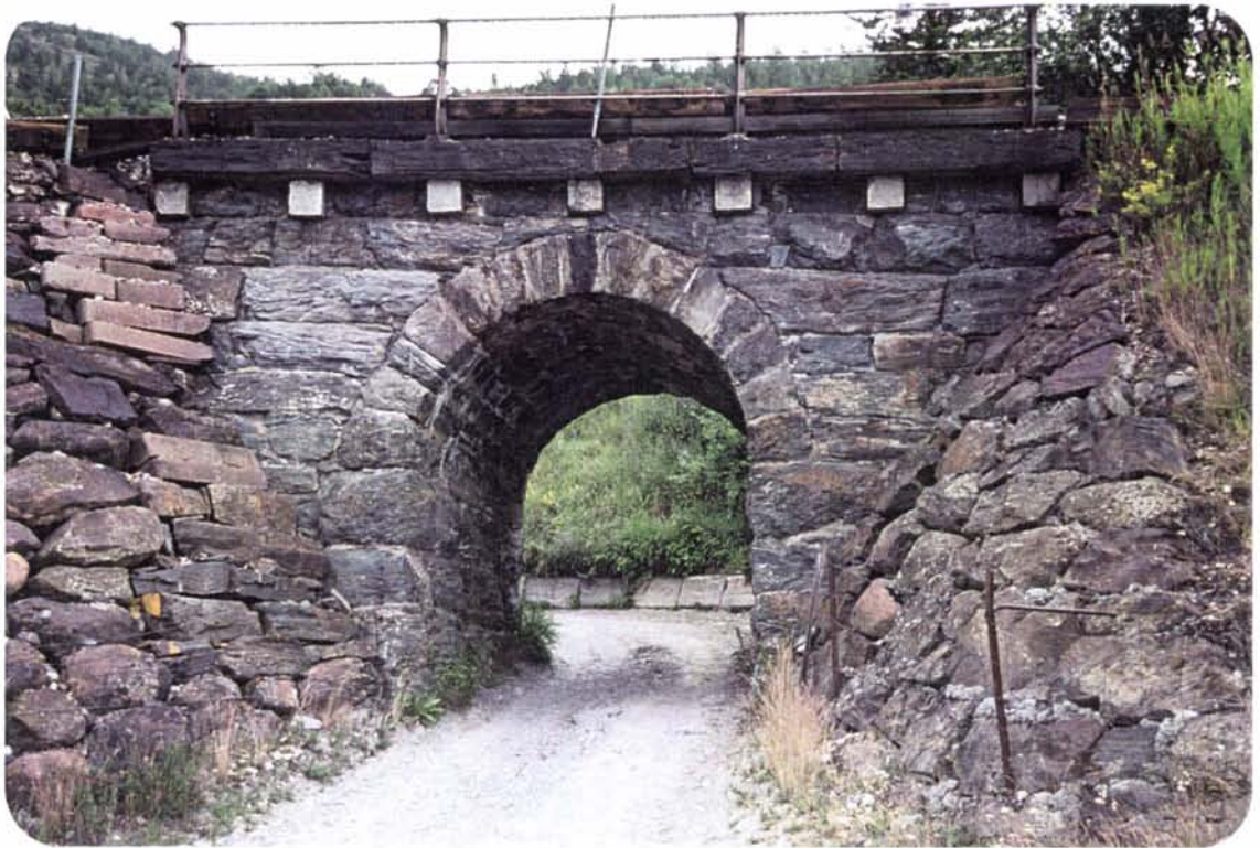
Foto 133: Undergangskulvert ved Skjelle.
