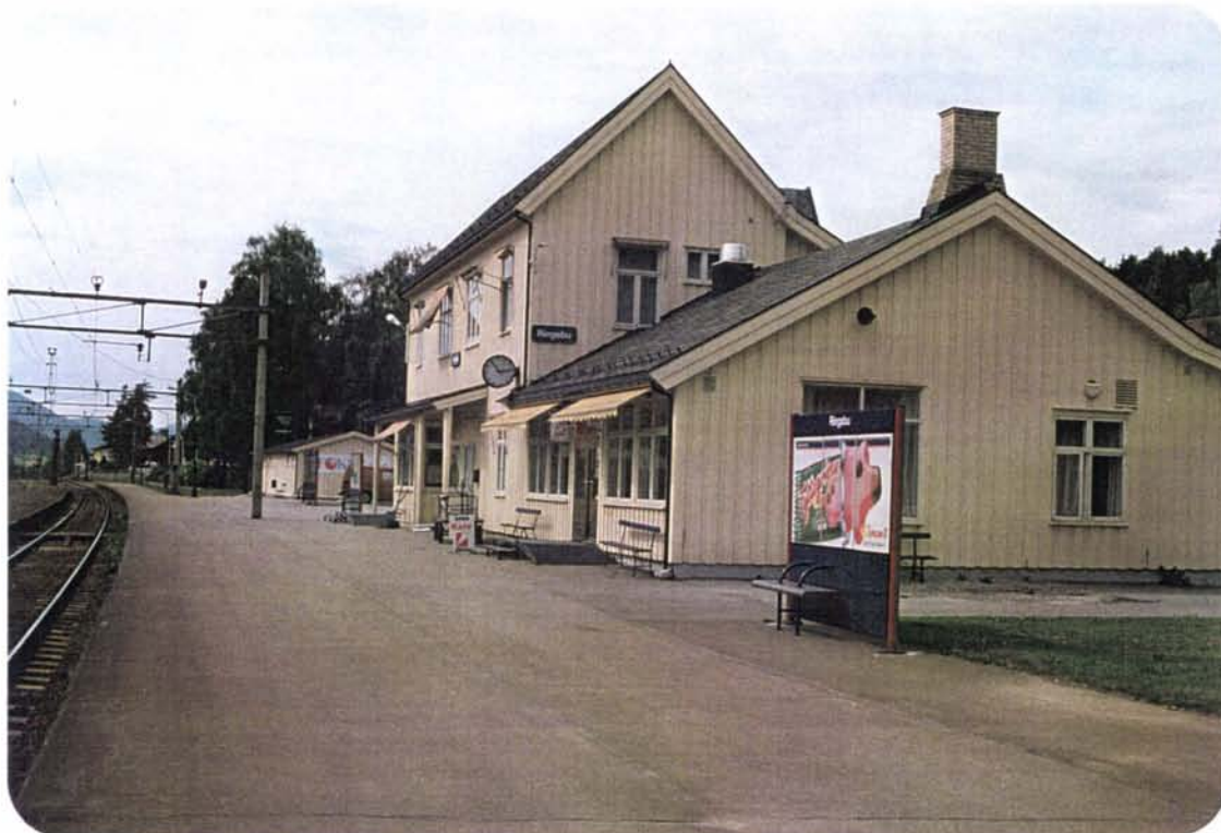
Foto 75: Persontrafikkdelen av Ringebu stasjon framstår som tiltalende og enhetlig, på tross av ombygninger og etappevis utbygging. Fargebruk, takbelegg, vinduer og utv. kledning binder idag husene sammen.
