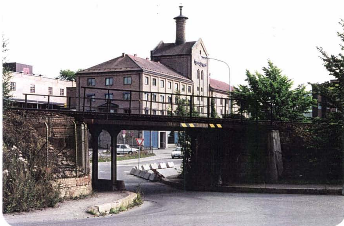
Foto 3 og 4: To øst-vestgående terrengrygger gjennom Hamar gjør at jernbanen delvis er lagt som høgbane på fyllinger, og delvis i skjæringer. Kryssende kjøreveger er lagt i kulverter under jernbanen. Gangvegen nedenfor krysser jernbanen på overgangsbru i den lange skjæringen nord i byen.
