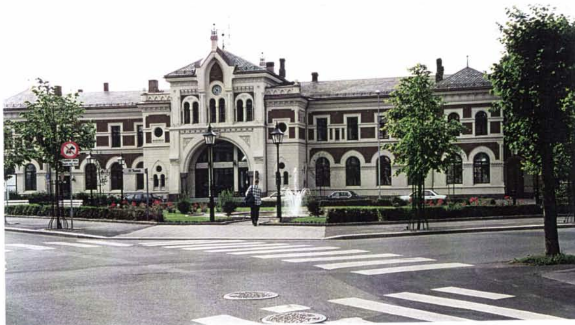
Foto 2: Stasjonsbygningen ved Hamar st. ble oppført i forbindelse med Gudbrandsdalsbanens anlegg (1895). Den er nylig restaurert. Stasjonsbygningen er foreslått fredet av NSB.
