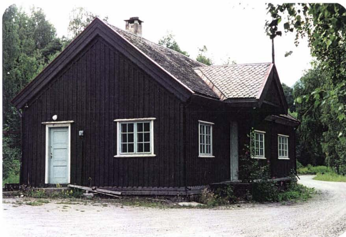
Foto 120: Uthuset ved stasjonen er holdt i samme formspråk og farger som stasjonsbygning og godshus.
