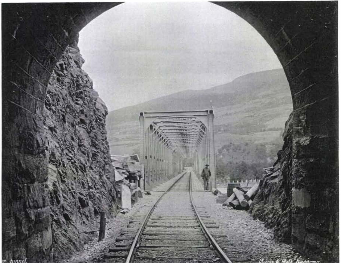
Foto 66: Randklev tunnel og bru fotografert i anleggstiden.
