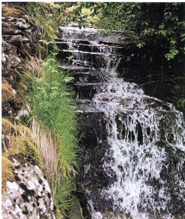
Foto 60: Sør for stasjonen er en bekk lagt i kulvert under banen. Bekken er steinsatt som et kaskadeanlegg.
