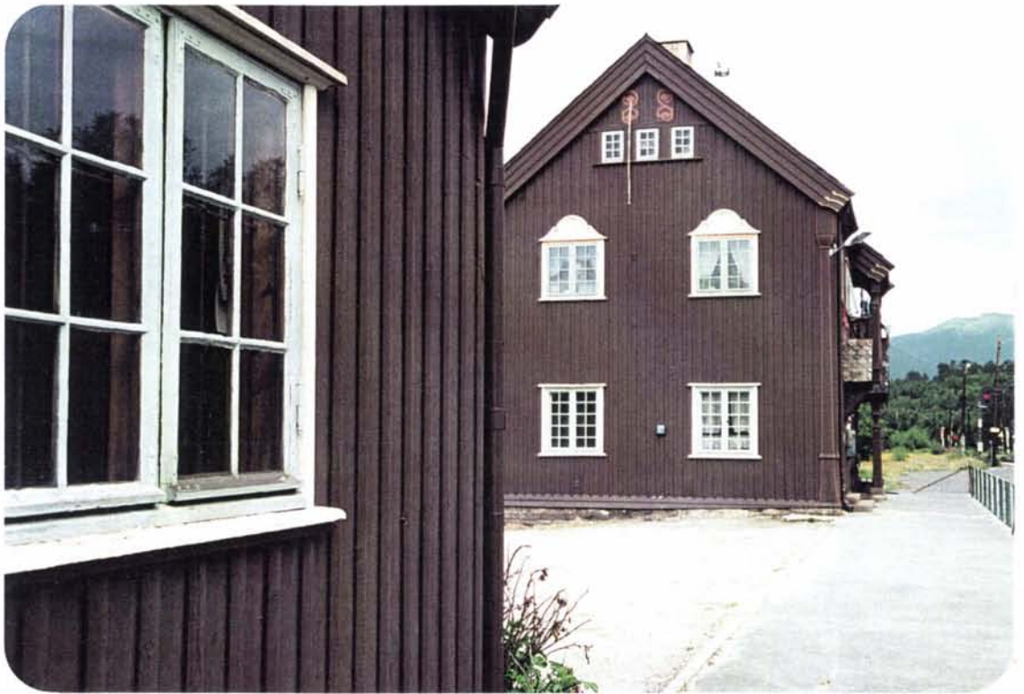
Foto 126: Brennhaug stasjon 1994. Bygningene er godt vedlikeholdt, men vindusskoddene er tatt vekk i årenes løp.
