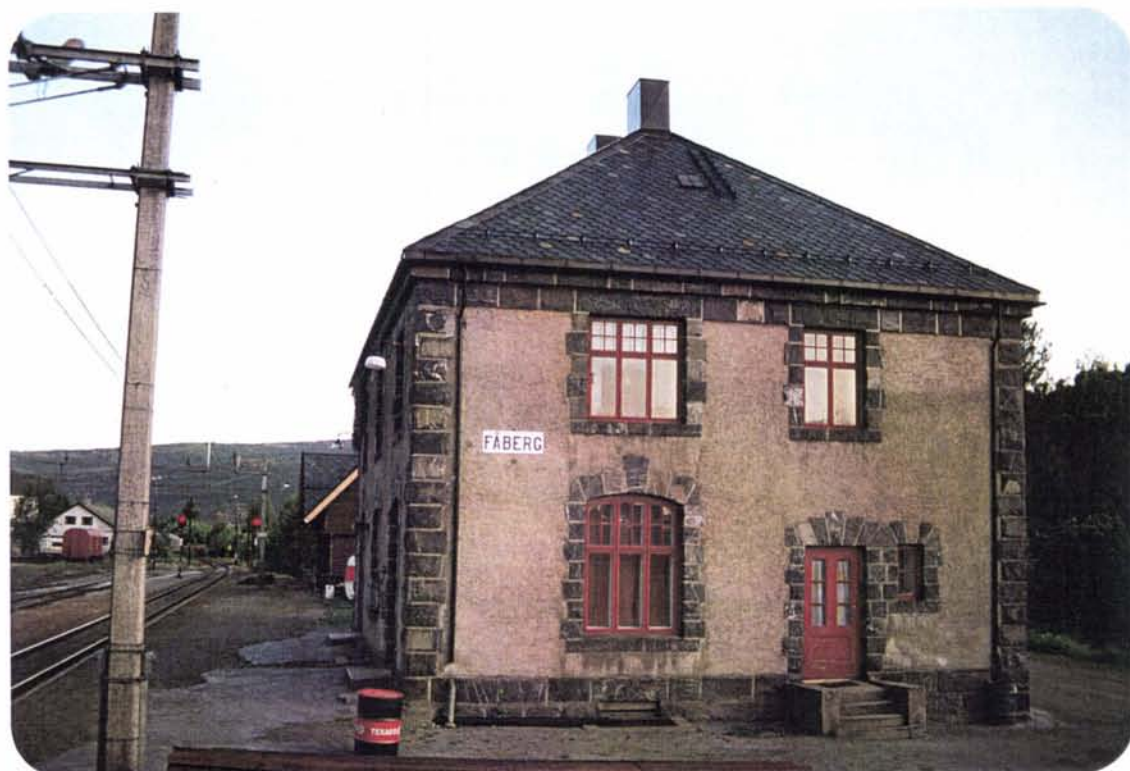
Foto 32: Stasjonsbygningen ved Fåberg er oppført i betong med kvadersteinsdetaljer og valmet tak. Dette gir stasjonen en helt annen identitet enn de øvrige mellomstasjonene hvor Paul Dues stasjonsbygninger ennå står.
