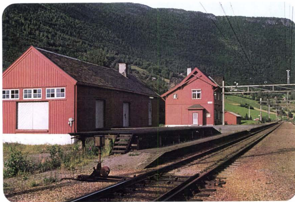
Foto 95: Kvam stasjon; et helstøpt bygningsmiljø som kan videreutvikles med en opparbeiding av utearealene og bedret kontakt med tettstedet.
