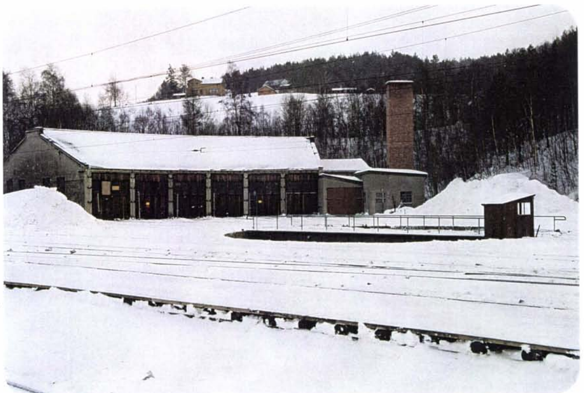
Foto 135: Den gamle rundstallen med svingskive er idag den mest interessante bygningen ved Dombås stasjon.
