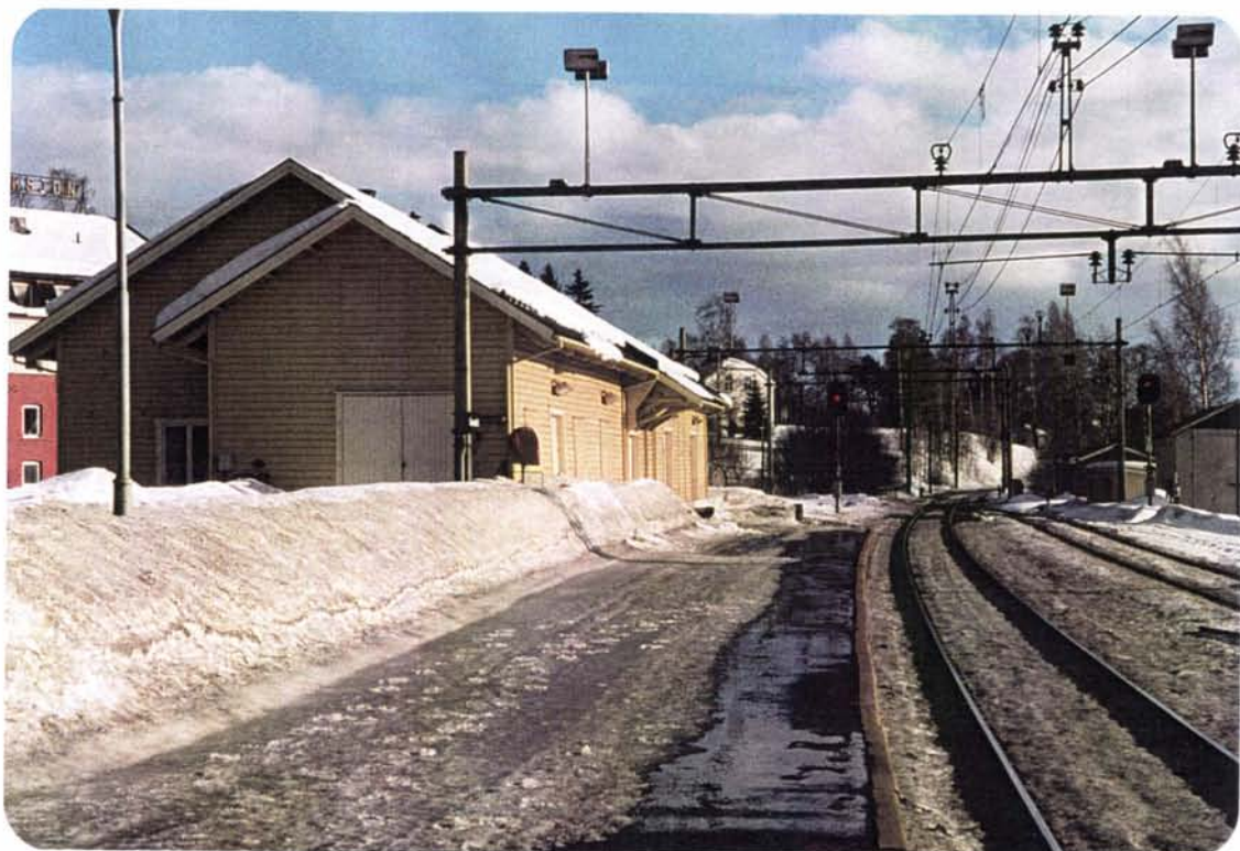
Foto 9: Det opprinnelige godshuset ved Brumunddal stasjon er lite ombygd og godt vedlikeholdt, og er idag et viktig kulturminne og en levende historisk dokumentasjon.
