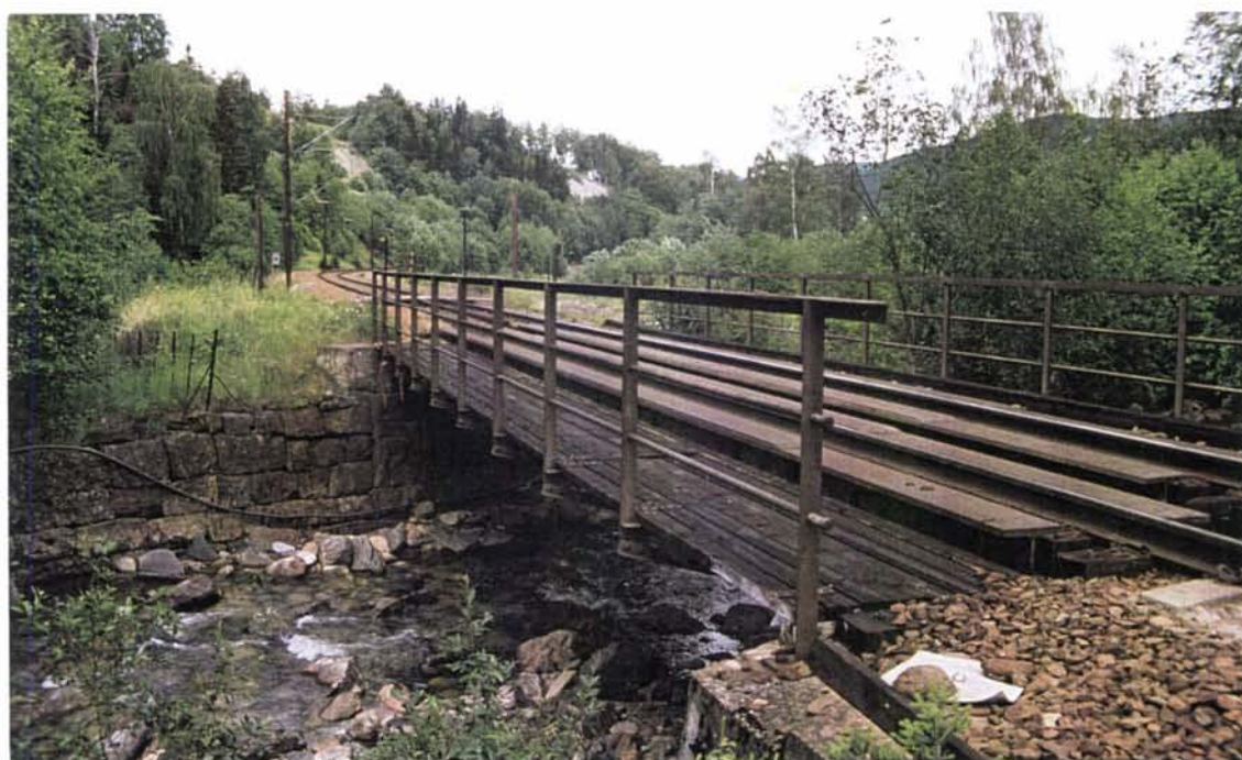
Foto 62: Bru over Moelva sør for Fåvang. De mindre bruene på banestrekningen er uanselige bjelkebruer på murte landkar. De er lite spennende som landskapselementer, men ved sin anonymitet glir de godt inn i landskapet. Mellom Moelva og Årnes (lenger sør) ligger Fåvang landskapsvernområde mellom banen og Losna.
