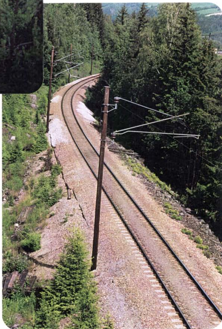
Foto 38: Et typisk bilde av jernbanen gjennom Gudbrandsdalen, tatt sør for Øyer. Rustfarget pukballast, betongsviller og kreosotimregnerte stolper er de viktigste elementene. Banen er kurverik og ligger enten i åpent jordbrukslandskap eller som her omsluttet av bar- og blandingskog.
