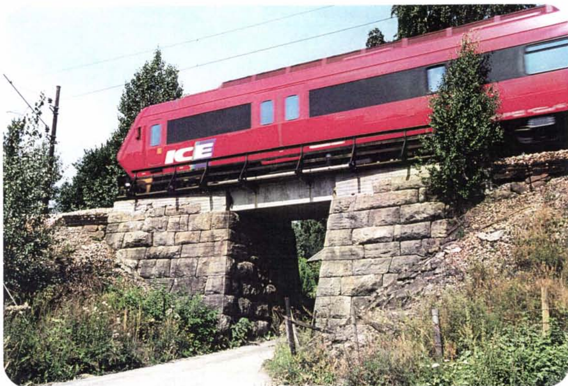
Foto 15: Murt kulvert for lokalveg ved Ringsaker stasjon. Stålbjerkene er byttet ut med betongtrau i den senere tid.
