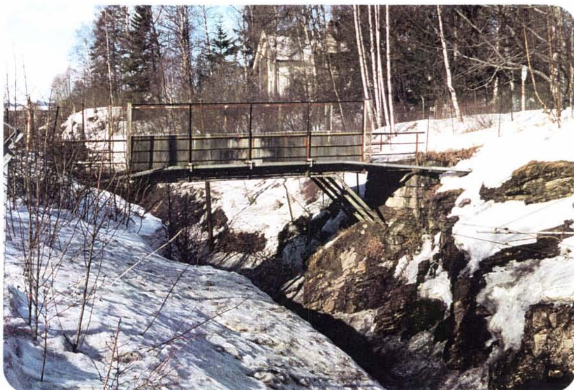
Foto 3 og 4: To øst-vestgående terrengrygger gjennom Hamar gjør at jernbanen delvis er lagt som høgbane på fyllinger, og delvis i skjæringer. Kryssende kjøreveger er lagt i kulverter under jernbanen. Gangvegen nedenfor krysser jernbanen på overgangsbru i den lange skjæringen nord i byen.
