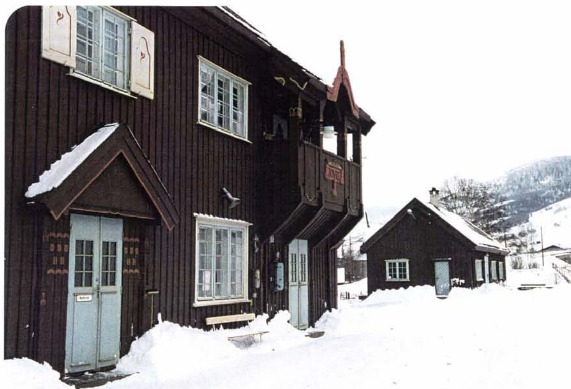
Foto 131: Stasjonsbygning og godshus ved Dovre st. er foreslått bevart. Merk den frodige utsmykningen av bygningsdetaljene. Vindusskoddene er her intakt.
