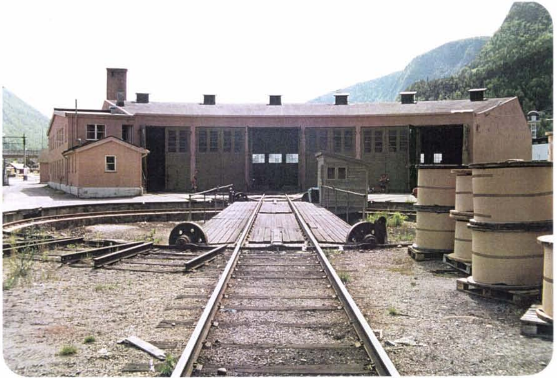
Foto 112: Svingskiven og rundstallen utgjør sammen er et spennende innslag ved stasjonen. Rundstallen danner en viktig nordvegg for stasjonens utendørs publikumsarealer.
