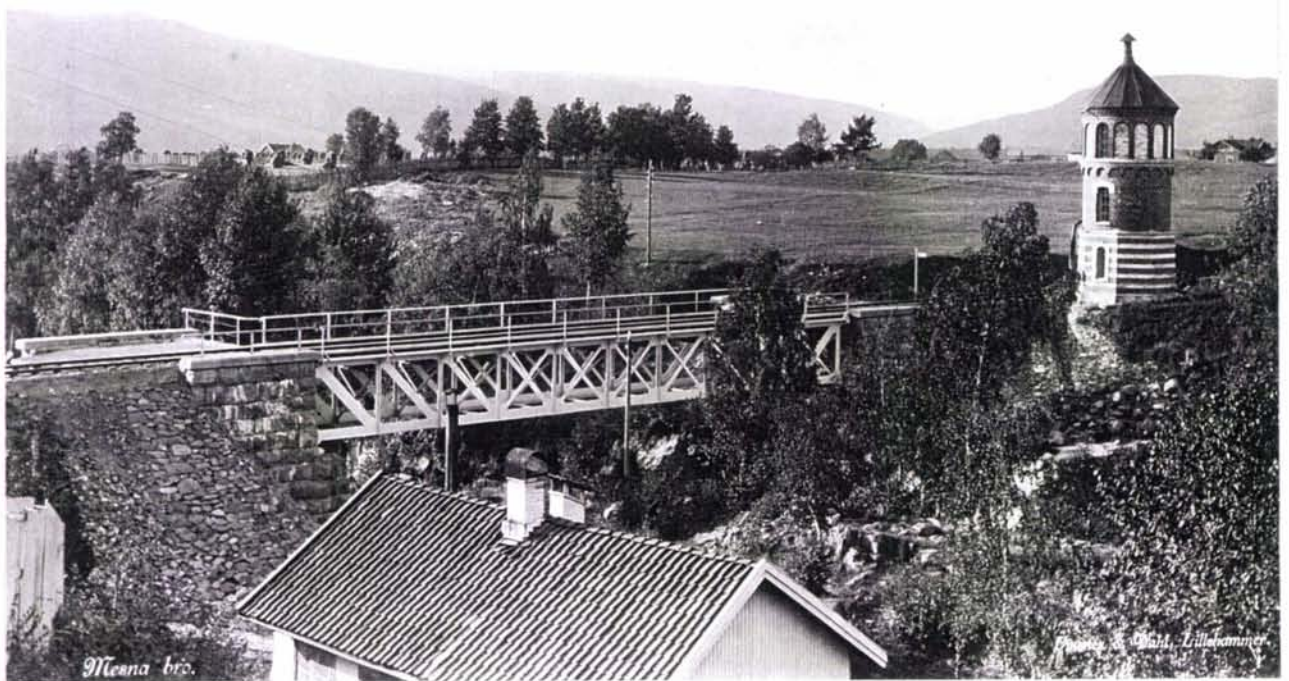
Foto 29: Foto fra århundreskiftet av Mesna bru og vanntårnet.
