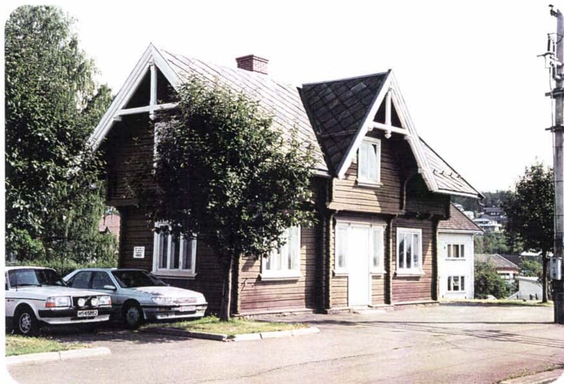
Foto 21: Ilgodshuset ved Moelv stasjon står ennå som en reminisens fra tidligere tider. Den nyplantede asalrekken gir et grønt preg, men er et noe fremmedartet innslag på dette stedet.
