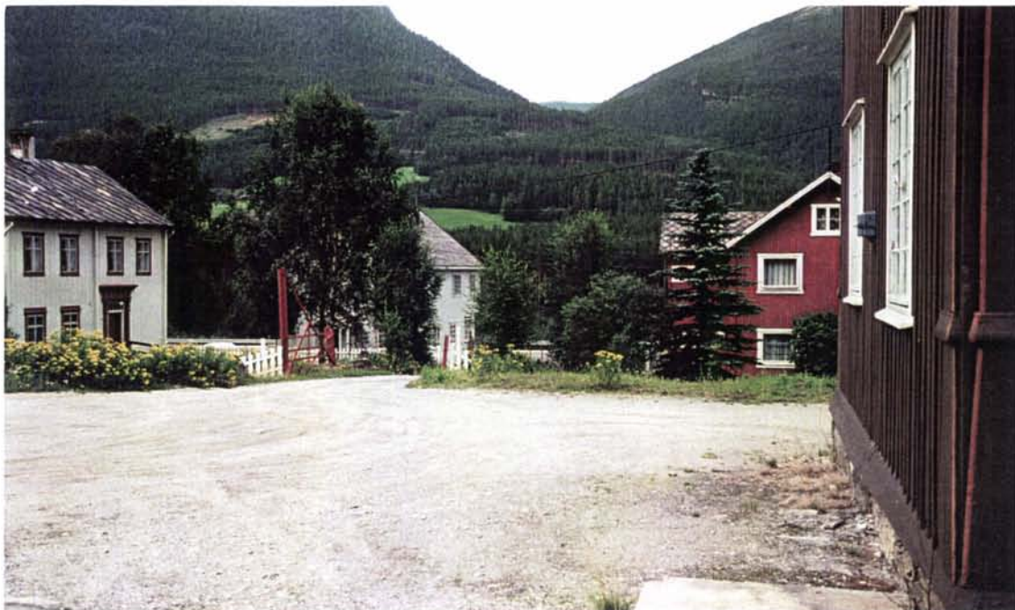
Foto 128: Ved Brennhaug stasjon ligger en husklynge som sammen med stasjonens hus utgjør et enhetlig bygningsmiljø
