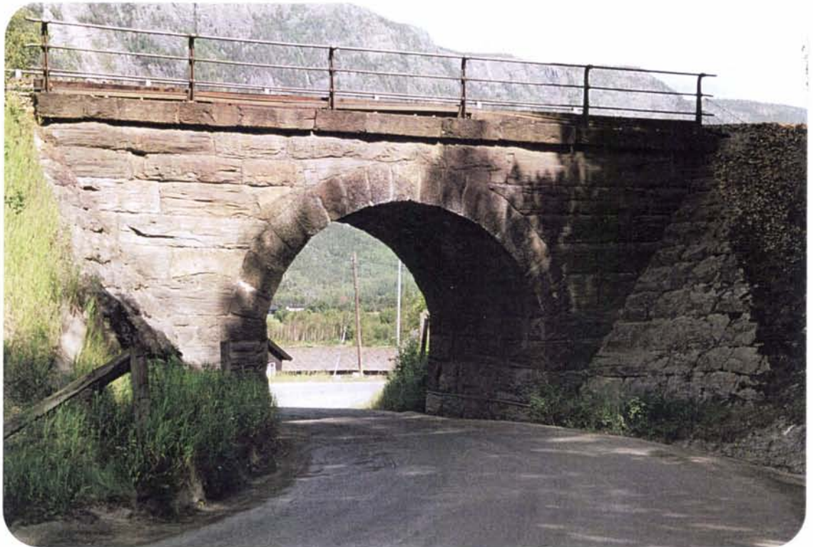
Foto 121: Steinhvelvkulvert over lokalvegen nord for Sel stasjon er murt av lokal naturstein.
