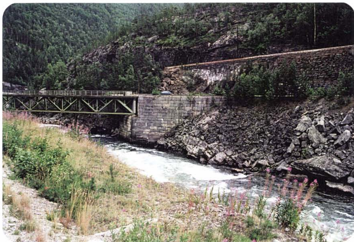
Foto 123: Støttemurene for jernbanen samspiller fint med brukarene og stålfagverket på den gamle riksvegbrua.
