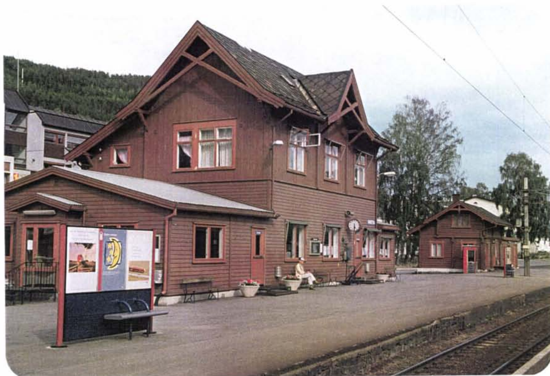
Foto 89: Vinstra stasjon. Stasjonsbygningen har gjennomgått endel uheldige om- og påbygninger gjennom årene. Eksteriøret bør kunne forbedres ved neste korsvei.
