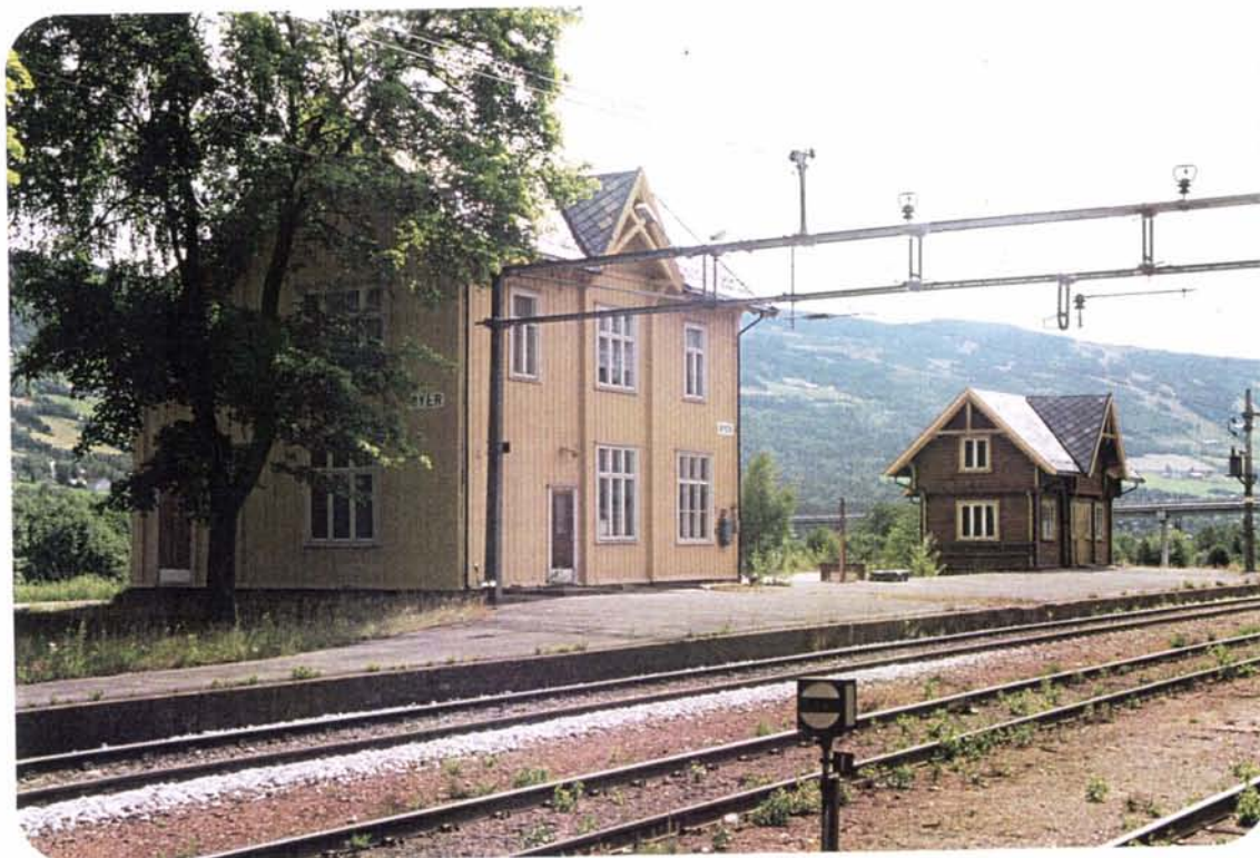
Foto 40: Stasjonsbygningen og ilgodshuset ved Øyer st. er de opprinnelige, tegnet av arkitekt Paul Due.
