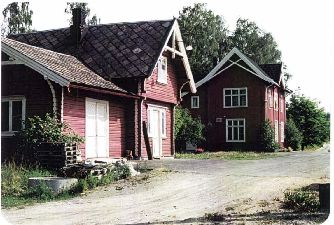
Foto 25: Bergseng stasjon med ilgodshus og stasjonsbygning. Ilgodshuset er større enn ved de øvrige mellomstasjonene langs banen; hovedfløyen er tverrstilt, og har fått en énetasjes fløy langs perrongen. Legg merke til prydbuskene på stasjonsområdet og bjørkerekken i eiendomsgrensen bak bygningene.
