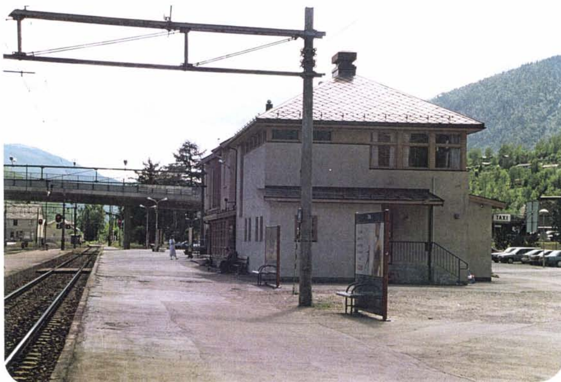
Foto 111: Stasjonsbygning og ny skysstasjon er sammenbygd i et enhetlig formspråk.
