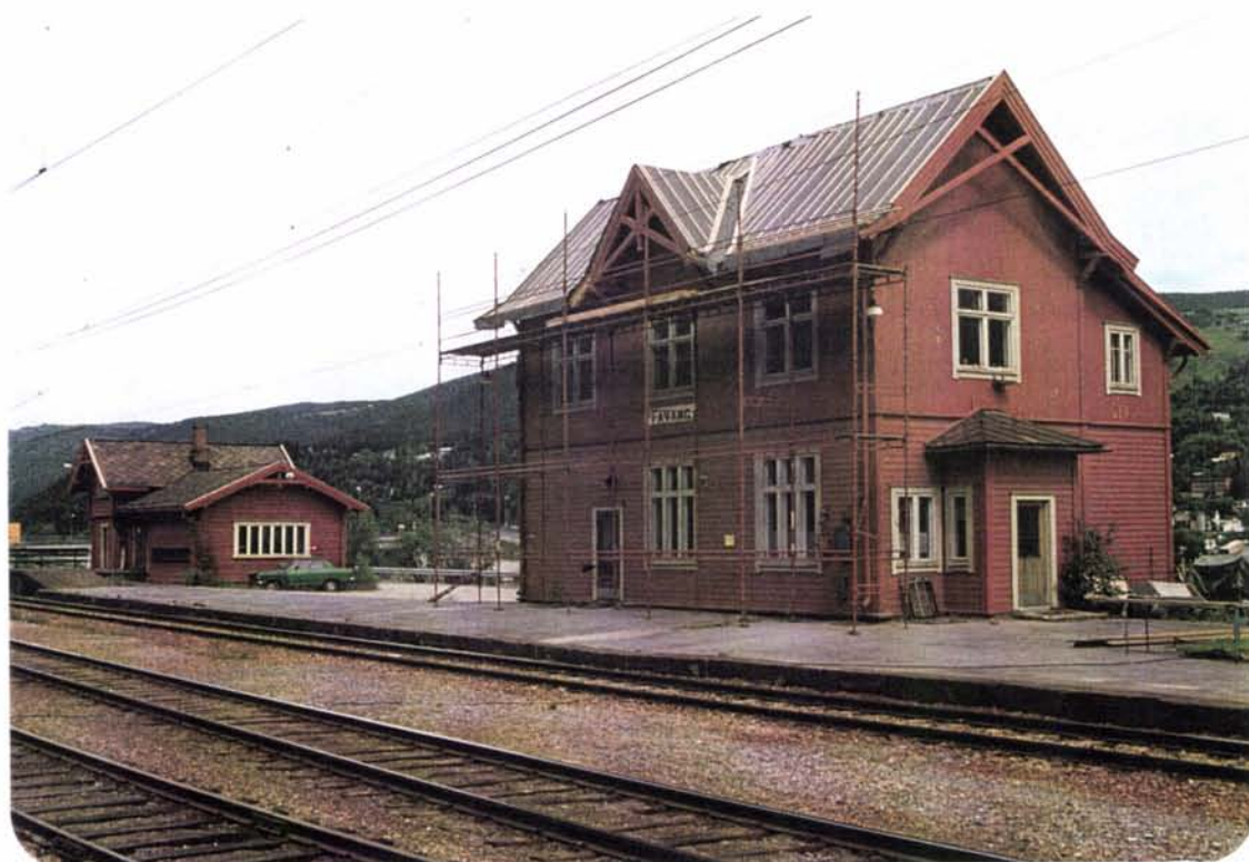
Foto 65: Fåvang stasjon med ilgodshus og stasjonsbygning.
