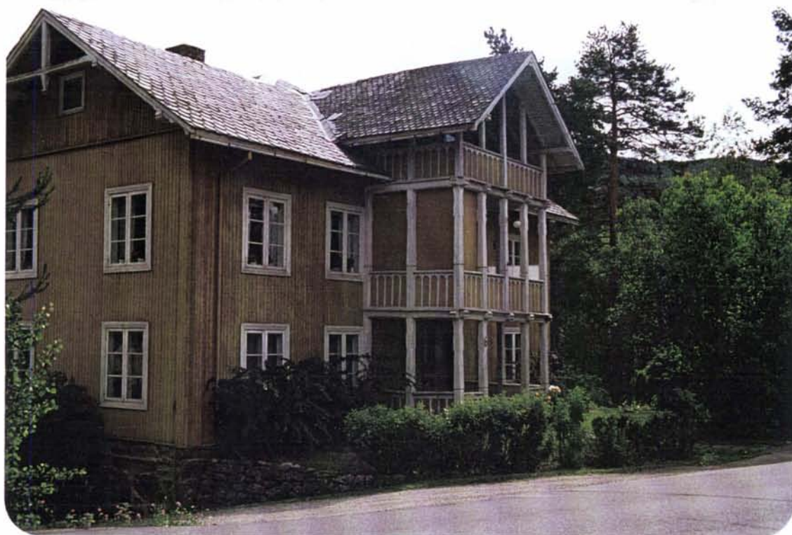
Foto 51: Et ruvende og karakterfullt hus med sveitserveranda like ved Tretten stasjon.
