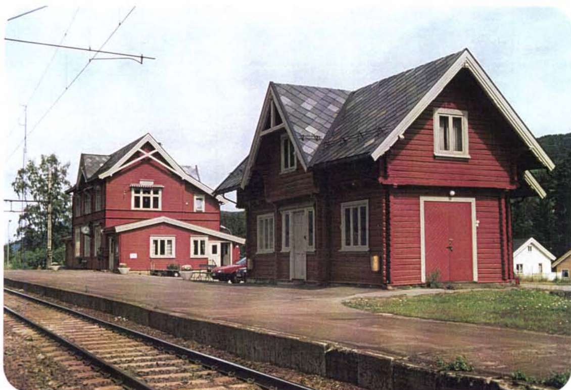
Foto 45: Ilgodshus og stasjonsbygning ved Tretten st.
