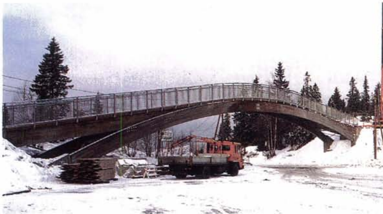
Ei trebru er relativt enkel å demontere og gjenbruke. Fotografiet under viser ei trebru over Sandvikselva. Fotografiet over viser den samme brua under montasje etter flytting
