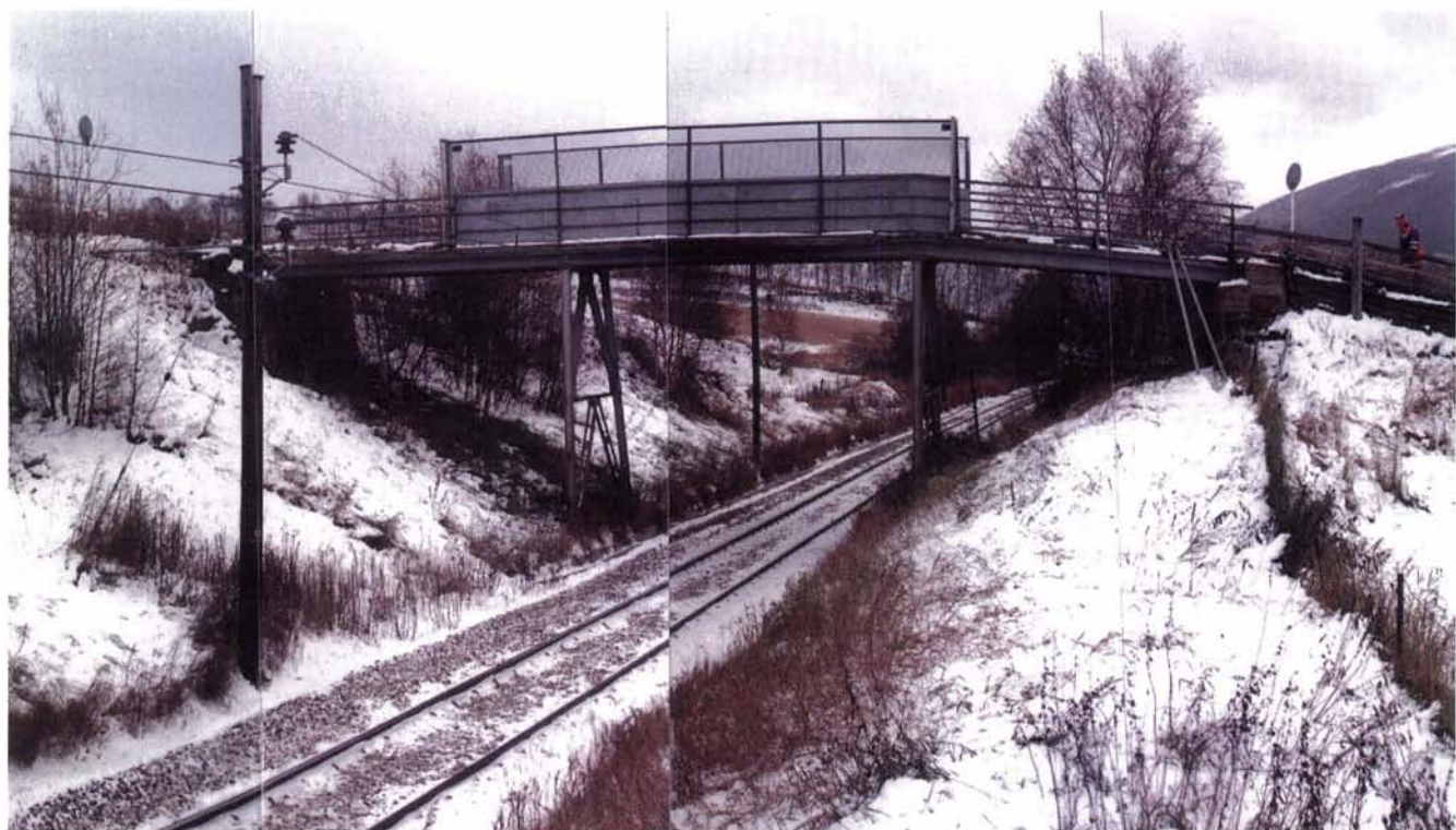
Fig 4.4.2. Typisk eksempel på eksisterende stål- bru i 3 spenn som kan være aktuell for utskifting
