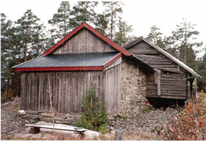
Figur 13 Den lille driftsbygningen på Kornbråten (Grønnhella) består av steinfjøs og en femvegget tømmerlåve. Muringen kan tyde på at fjøset er satt opp på 1600-1700-tallet
