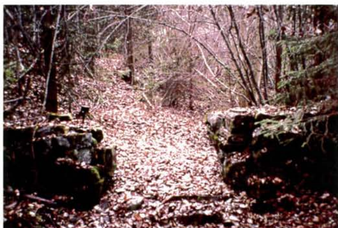
Figur 16 Ruin fra kjerratanlegget. Den berømte kjerraten i Åsa var i drift fra 1804 til 1849. Traseen vil kunne komme i konflikt med rester av kjerratanlegget
