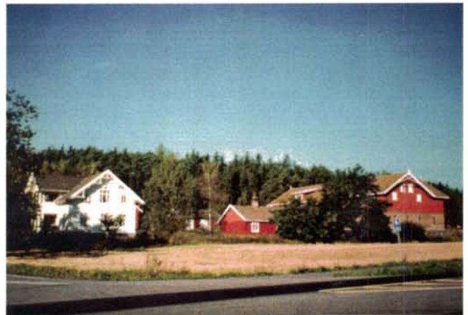
Figur 34 Det enhetlige og godt bevarte sveitserstilstunet på Sonerud har fått Fortidsminneforeningen i Buskeruds pris for god bevaring. De foreslåtte traseene over Steinsletta vil medføre at tunbebyggelsen må rives
