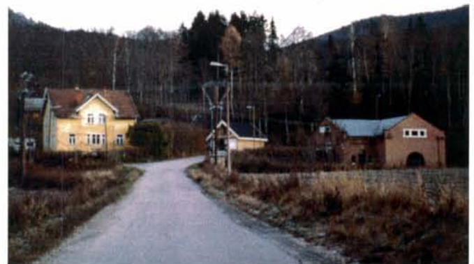
Figur 21 Kraftstasjonen i Åsa ble bygd ca 1910. Selve stasjonen ligger til høyre i bildet, bestyrerboligen på motsatt side av veien. En utvidelse av Stubdalsveien kan få konsekvenser for anlegget
