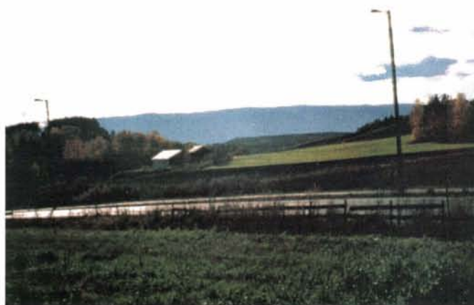
Figur 35 Trasealternativ 22B vil direkte berøre kulturlandskapet på vestsiden av E16. Den vil skjære gjennom redskapshusene til Øderå og gå inn i tunnel til høyre i bildet
