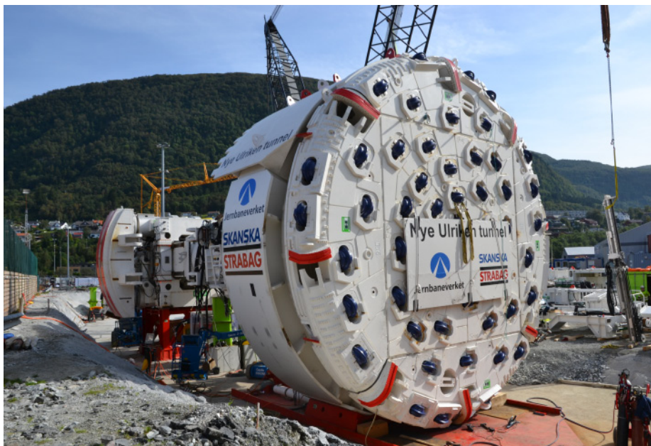
På anleggsområdet i Arna tar tunnelboremaskinen form. Monteringen foregår på en støpt betongplate som er 50 meter lang.
