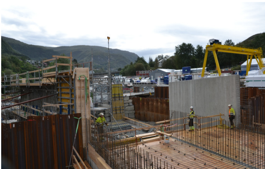
I Storelva i Arna pågår et omfattende støpearbeid for å bygge på vanntunnelen som leder elven under jernbanestasjonen.
