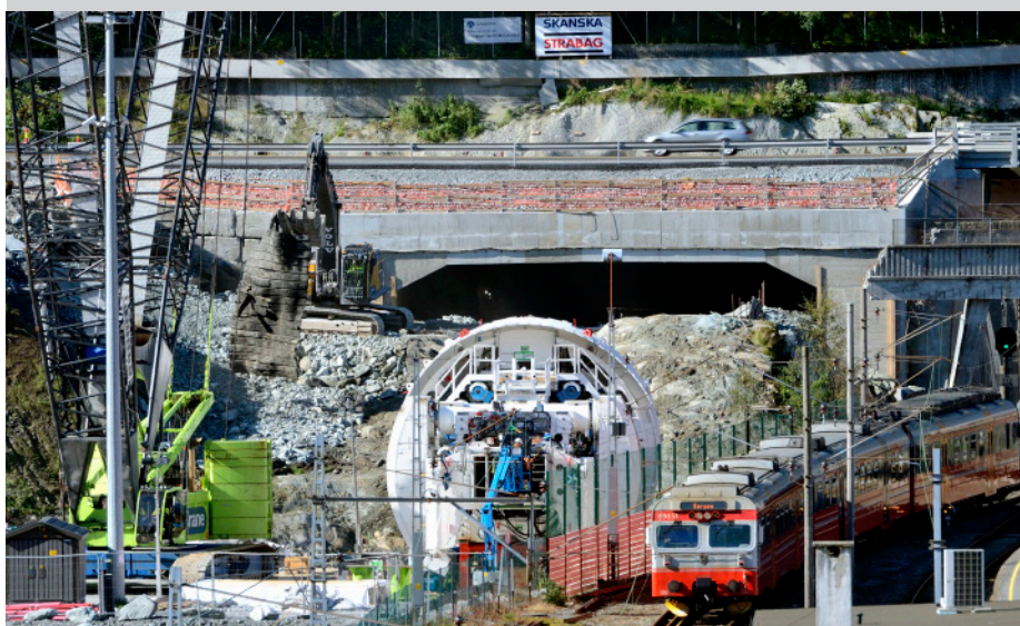
Monteringen av tunnelboremaskinen skjer side om side med togtrafikken. Fjellknausen mellom maskinen og tunnelåpningen fjernes slik at maskinen kan skyves inn i tunnelen.
