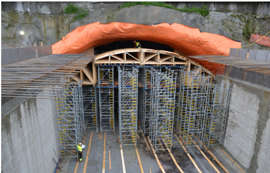
Foran åpningen til nye Ulriken tunnel forskales og støpes det tunnelportal. Når portalen er ferdig skal E16-Arnavegen legges tilbake over portaltaket.
