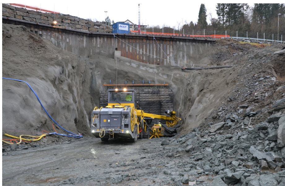
Tunnelarbeidet er godt i gang i Arna. Her står boreriggen foran tunnelåpningen som er dekket til med skytematter i forbindelse med sprengning.
