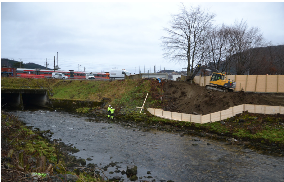
Langs Storelva er det satt opp gjerder og fiberduk for å hindre at masser glir ut i elven under arbeidet med å utvide vanntunnelen som går under Arna stasjon.
