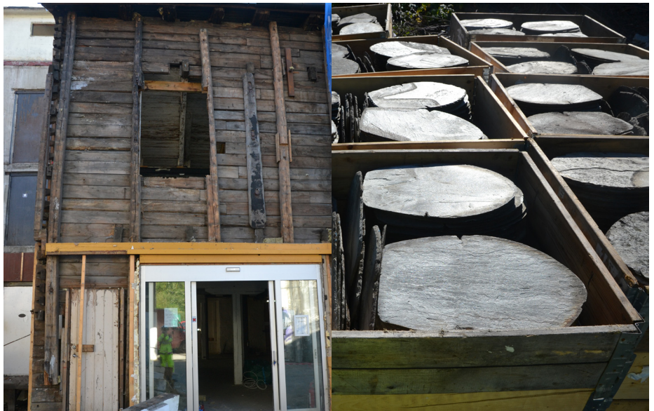
Kalfarveien 99 i Fløen: De antikvariske delene av bygningene skal bevares, som trekonstruksjonen på bildet til venstre. På bildet til høyre ligger skifer fra taket stablet i kasser klare for lagring.
