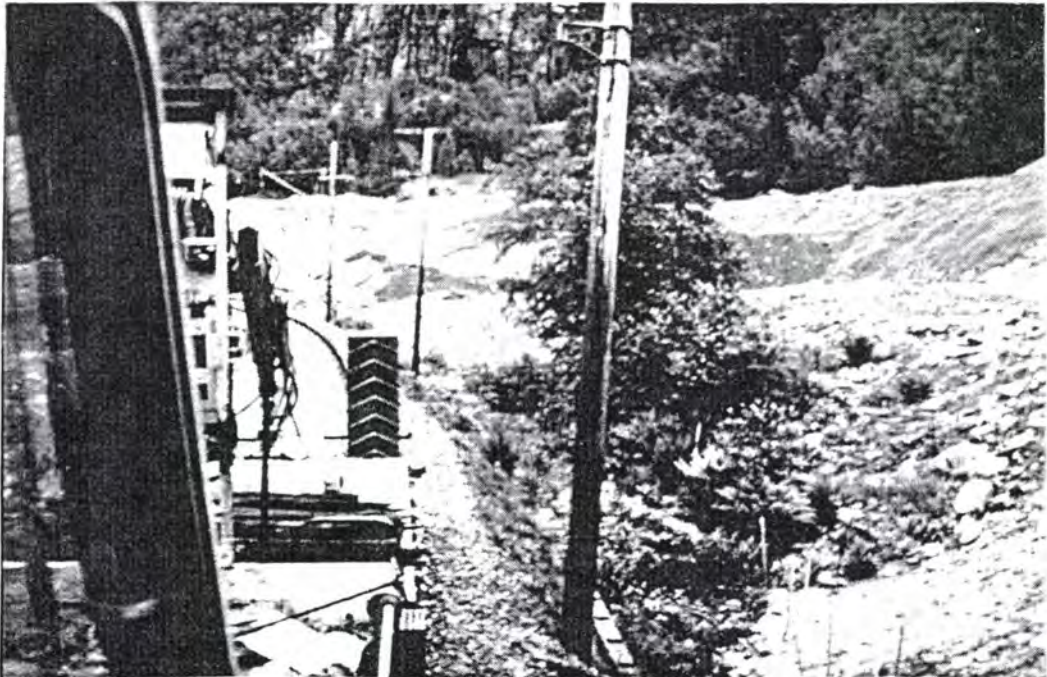
Foto 16. Merrhølen. Den nye riksvegen har fyllingsfot helt ned mot jernbanen. Vann kan demme seg opp mot jernbanefyllinga.
