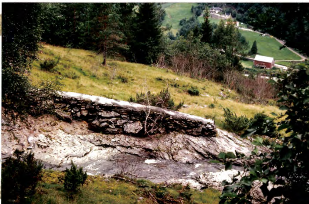
Foto 27. Slito ved kote 130-135. Bekken går i stryk over fjellgrunn. Gammel forbygning for å hindre overløp.
