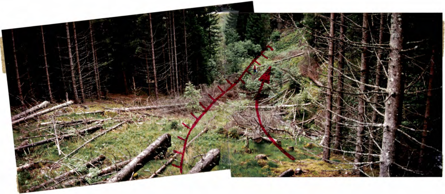
Foto 31. Kraftlinja med Slito's østre nedløp. Med ledevoll av løsmasser, rist av betong og stålprofiler og utskutt kanal vil det være mulig å bøye av og stanse hovedmassene i et sørpeskred som antydnet.
