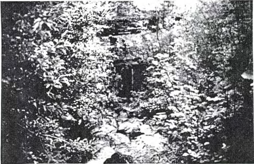
Foto 15. Storevikane (?) Grovblokkig bekkeløp med støpt kulvert. Busker og kratt vokser tett inn i løpet.
