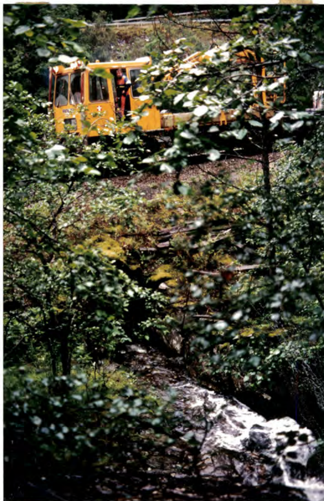
Foto 2. 394.600 Slito (Suto) Innløpet til kulvert.
