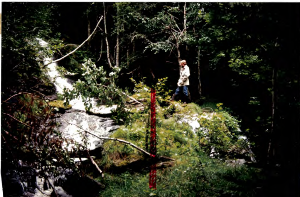
Foto 29. Slito ved bekkedelet ca. 100 m ovafor jernbanen. Sikringsmur kan plasseres langs senterlinja i bildet.
