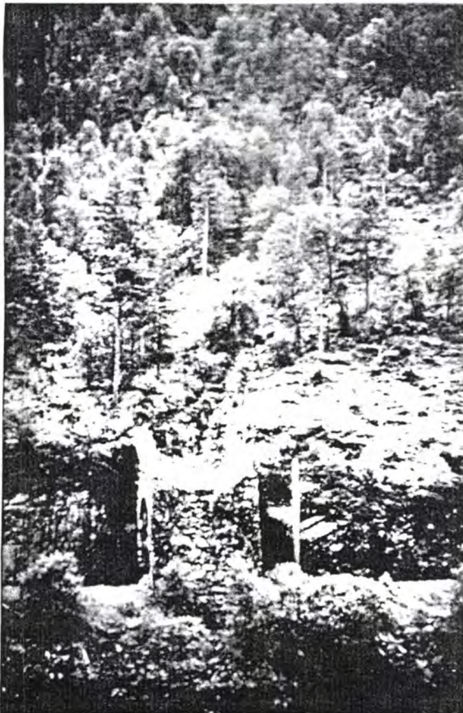
Foto 13. 402.300 Hvelv. Sikringstiltaket har fungert bra.
