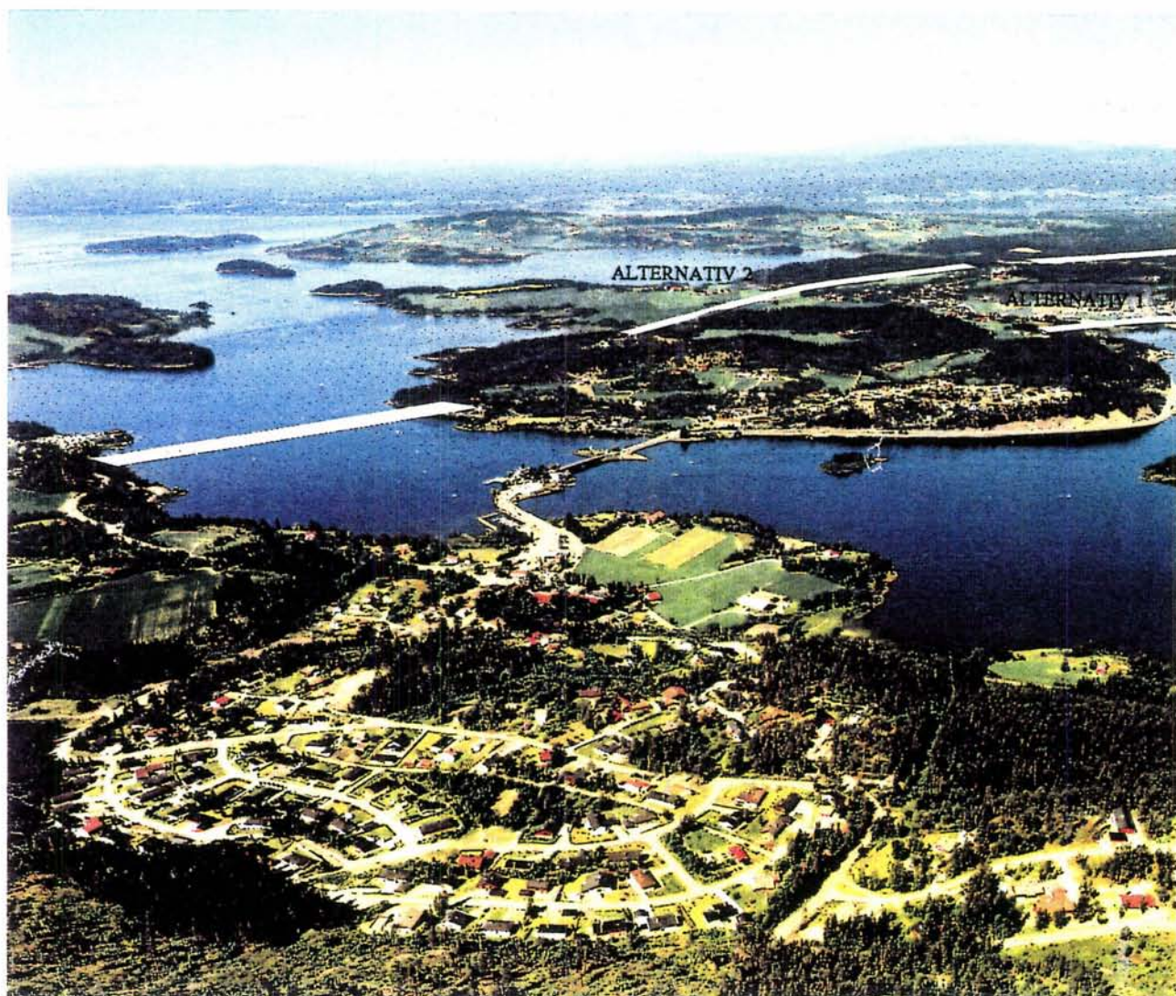
Ringerike sett mot vest. Sundøya midt på bildet. Brua over Kroksund, som er lik i alternativene 1 og 2, er markert til venstre på bildet.
