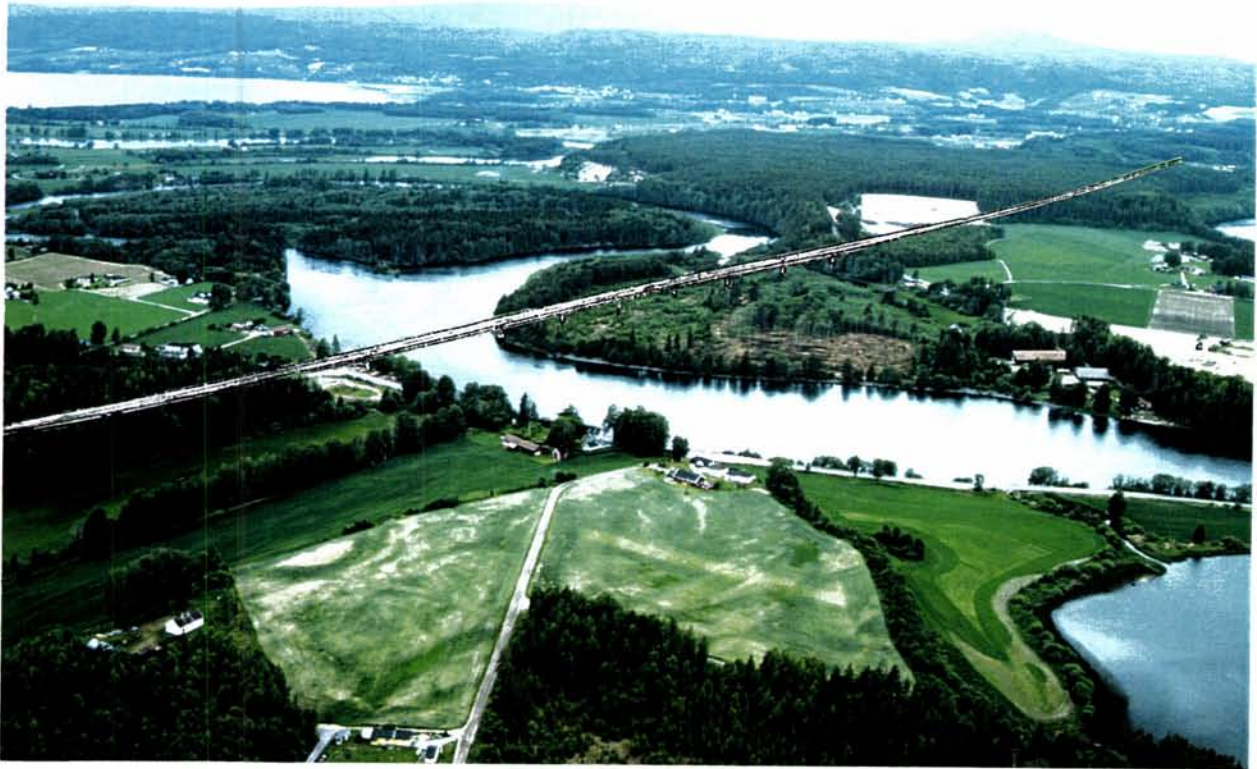
Bru over Storelva ved Busund sett mot vest.
