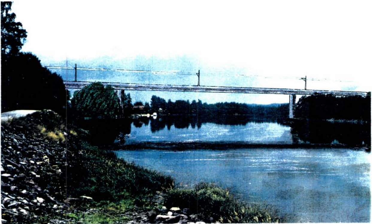
Bru over Storelva ved Busund sett mot vest. Se punkt 7 tegning 01.
