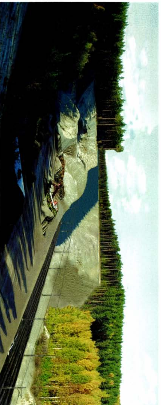
Bilde 35, Prestemoen. Jernbanen i en dyp skjæring gjennom et eksisterende masseuttak. Neste side: Revegetering vil dempe eksponeringen.
