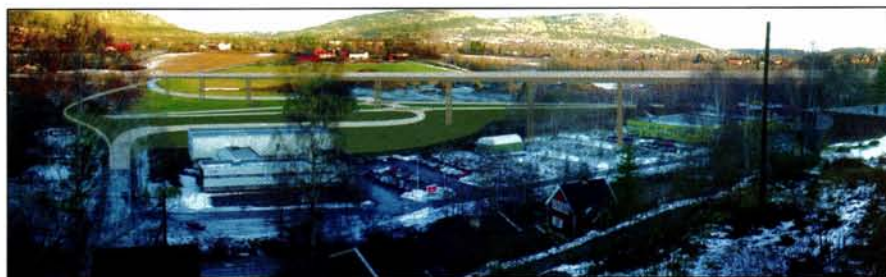
Figur 24 Bru over Skuidalen ved Økriveien, sett mot øst, med ny E16 og nytt kryss
