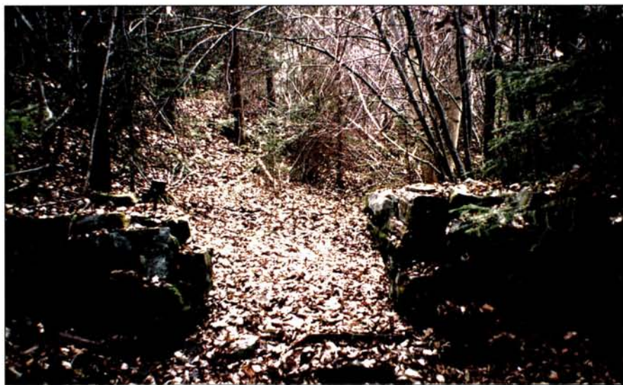
Figur 19 Ruin av Kjerraten i Åsa. Anlegget bestod av 11 vannbjul som dro tomme- ret opp fra Steinsfjorden til Damtjern. Slik kunne Peder Anker få tommeret fra skogene i Buskerud til Lysaker uten å fløte via Drammenselva
