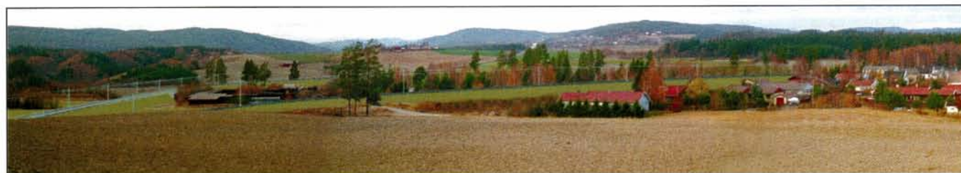
Figur 28 Norderhovlinja ved påkobling til Randsfjordbanen ved Tolpinrud
