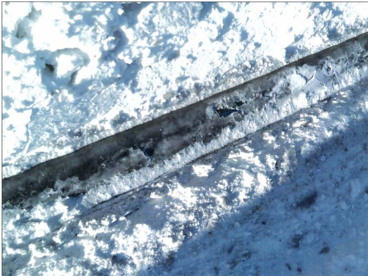
Figur 9: Bildet viser at det lå is på toppen av skinnehodet i sporet for sporfelt B etter at godstog 5512 hadde passert. (Kilde: Olav Haugen, Jernbaneverket)
