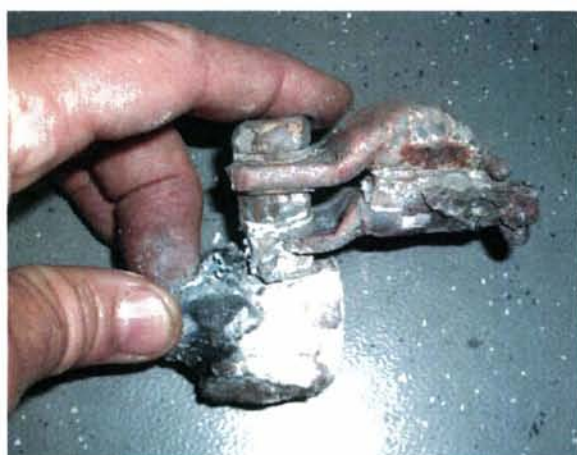
Figur 3: Viser koblingspunkt i koblingsboks.
