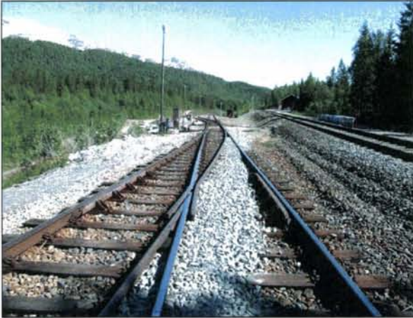
Figur 5: Sporet sett i retning fra gruveanlegget.
