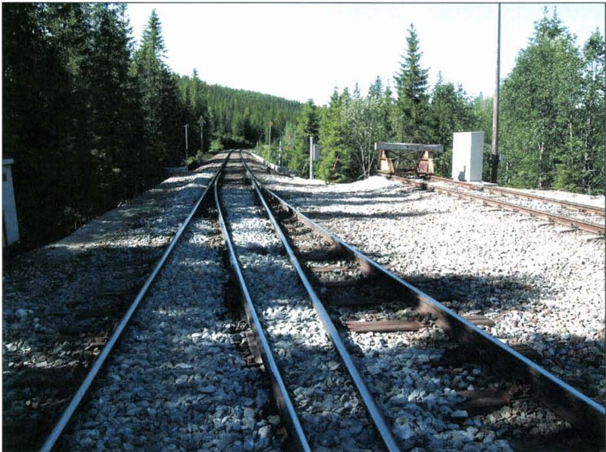
Figur 4: Viser Hovedsporet på Nordlandsbanen. Til høyre endebuttstokken som toget kjørte igjennom.
