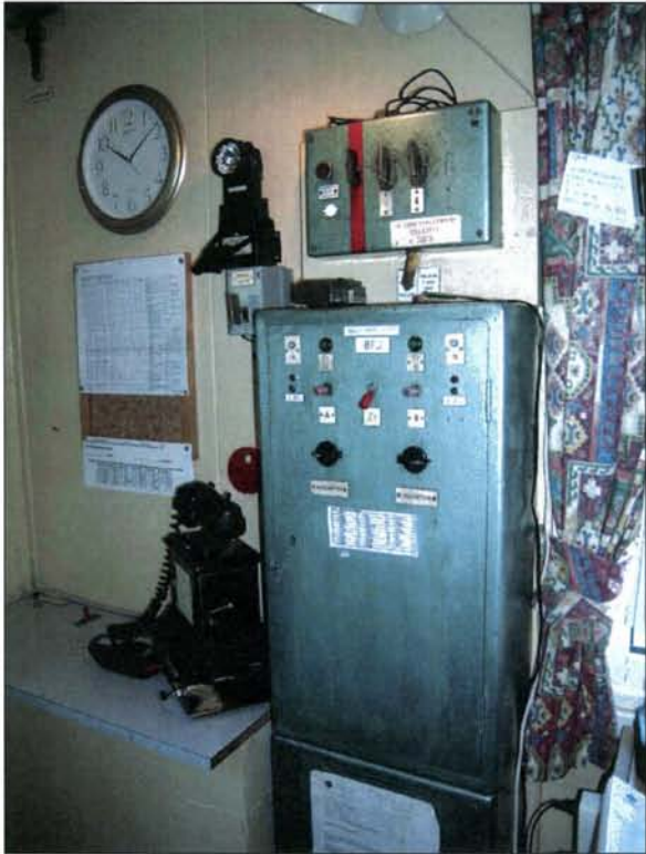
Figur 7: Stillerapparat for enkelt innkjøranlegg.
