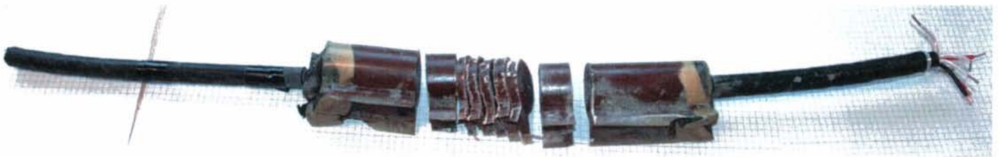
Figur 4 Oversiktsbilde av kabelskjøten etter seksjonering.
