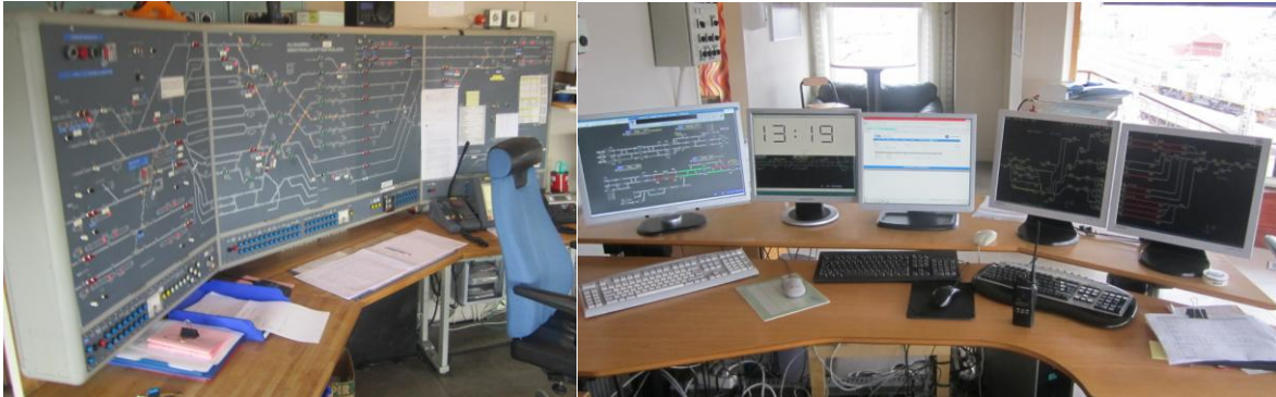
Figur 18 Stillerapparatet på Alnabru – analogt til venstre og digitalt til høyre
