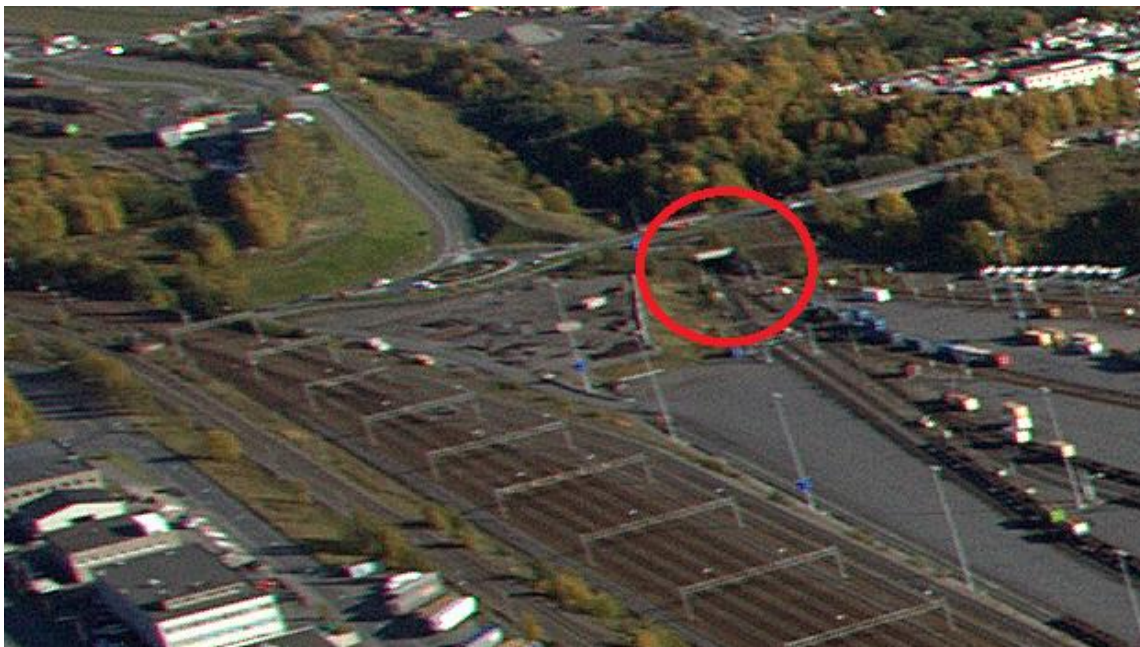
Figur 19 Tunnel under Nedre Kalbakkvei
