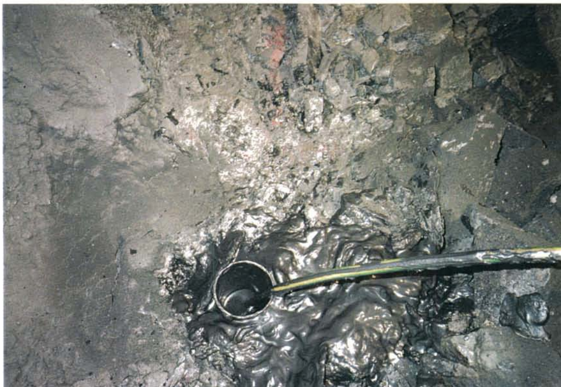
Bilde 5: Innstøping av 6 m jordspyd i Romeriksporten med elektrodemasse
