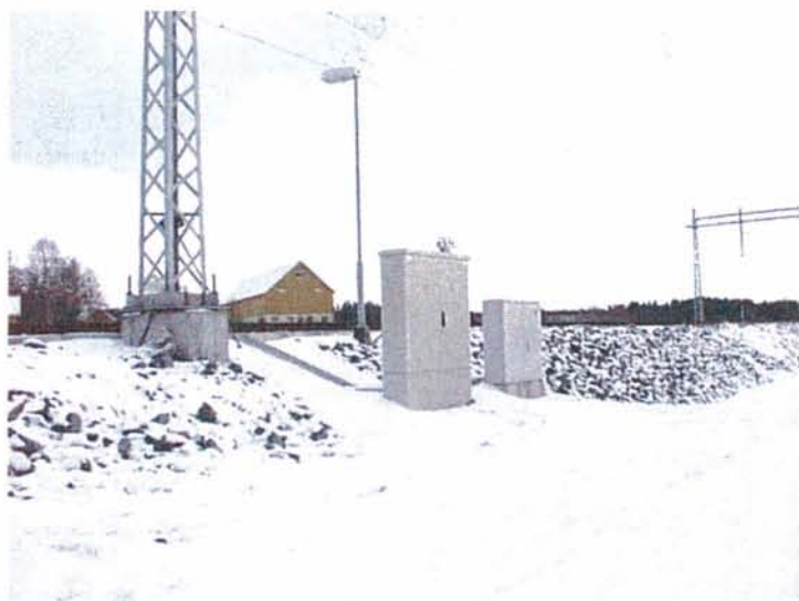
Bilde 1 Kontrollskap og trafoskap for Rygge
