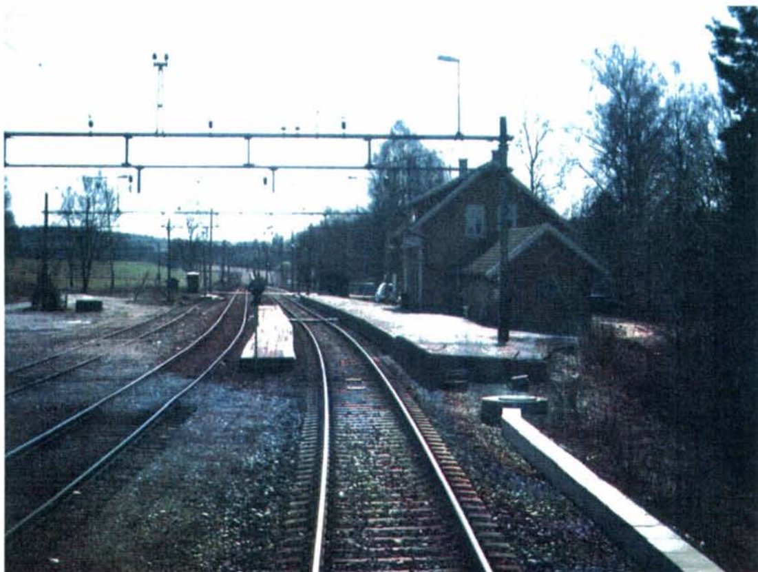
Figur 1 Bilde fra Kråkstad stasjon
