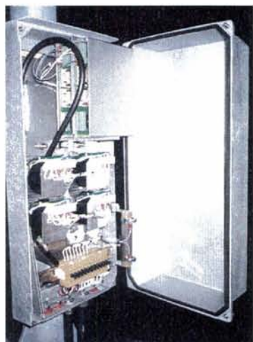
Figur 3 Signalskap med krets for fiktivt signal
