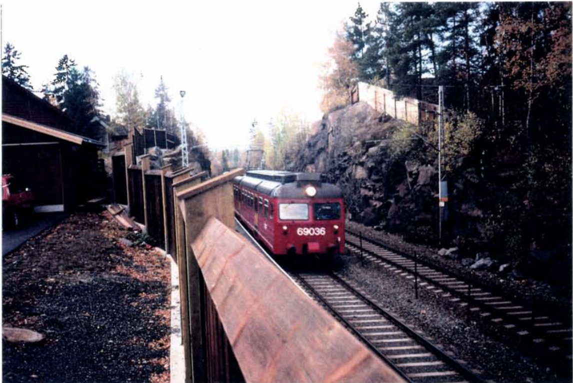
Figur 2.5 Absorberende treskjermer ved Hanaborg stasjon.
