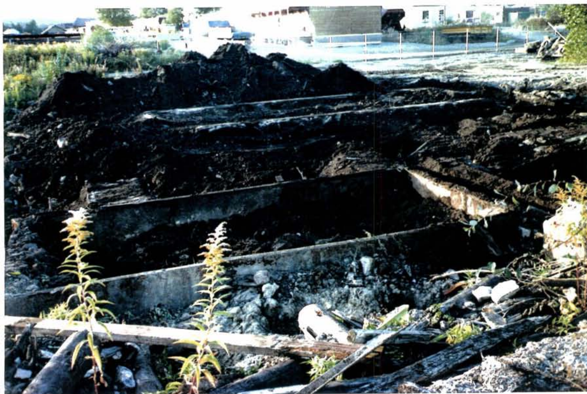
Oppgraving i F1. Funn av stål- og betongkar, innenfor spuntkasse.
