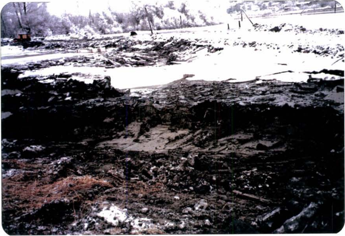
Oppgraving utenfor F2 (i regi av statens vegvesen Akershus).
