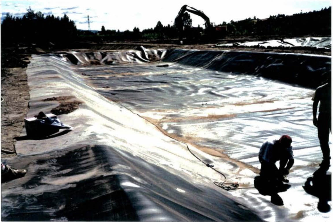
Etablering av deponier. Sveising av membran.
