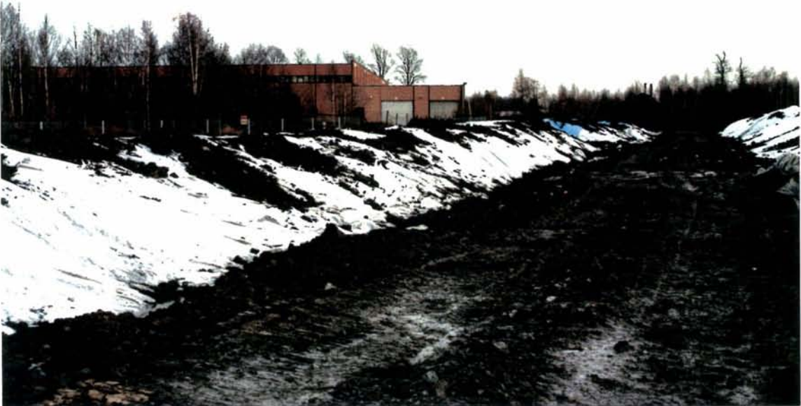
Deponier tildekket. Jord er lagt oppå deponiene for å holde presenningen på plass.
