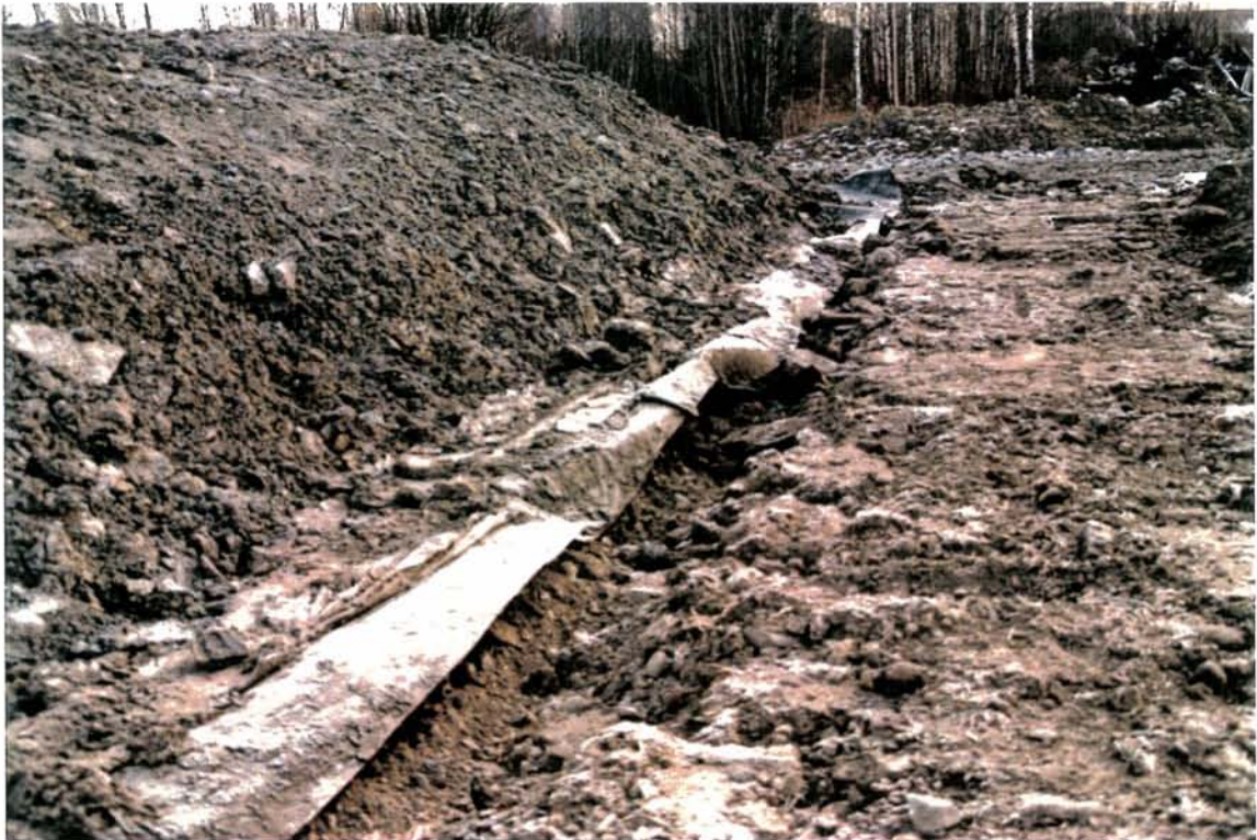
Deponi nr.7 klar til tildekking. Membran-kanten er gravd fram slik at presenningen som skal dekke til deponiet kan legges slik at vann ikke trenger inn i deponiet.
