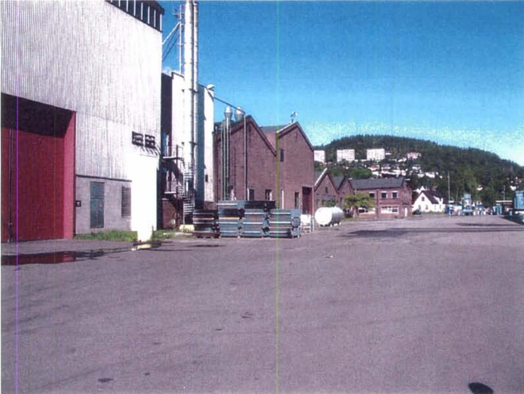
Figur V2-3: Området vest på Drammentomta med produksjonslokaler og verksteder tilhørende ABB til venstre i bildet. Drammen kommune, 2003.
