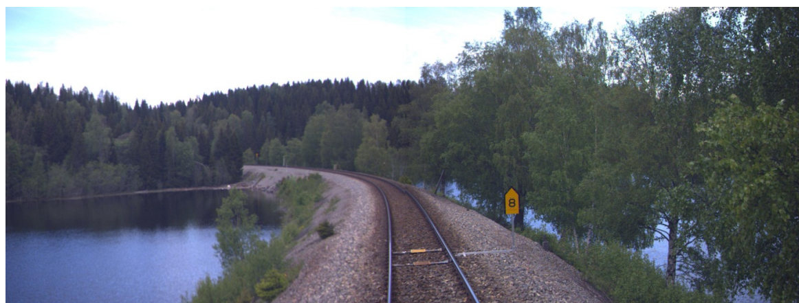
Jernbanen kjører ofte nært vann, slik som her langs Nordlandsbanen. Dette gir utfordring for riktig bruk av plantevernmidler. Foto: Jernbaneverkets målevogn.
