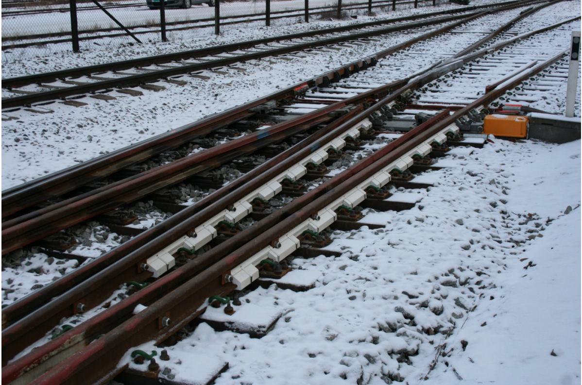
Spurveksel med isolering, Hamar stasjon. Foto: Amund Korsbakken, Jernbaneverket
