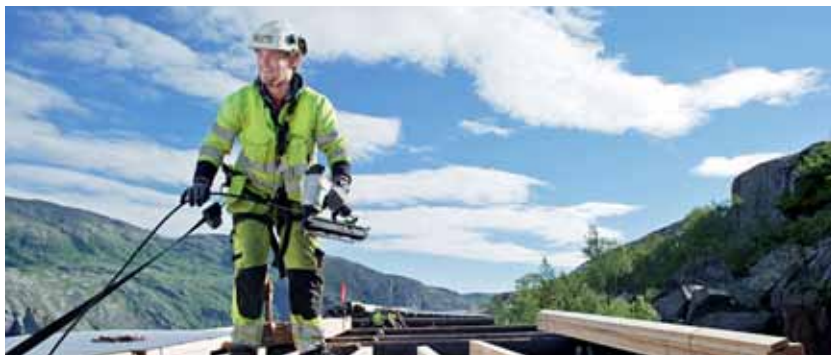
Snøoverbygg, Ofotbanen. Foto: Hilde Lillejord/Jernbaneverket
