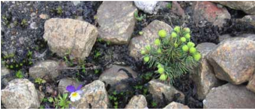
Vegetasjon i ballasten. Foto: Veronica Valderhaug/ Jernbaneverket
