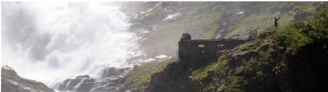
Kjosfossen. Foto: Øystein Grue/Jernbaneverket
