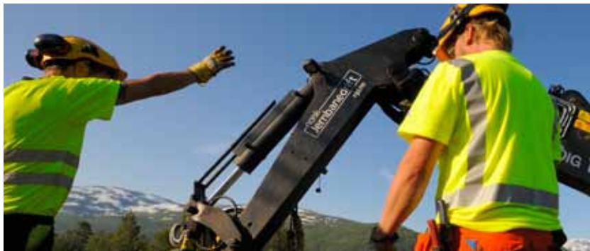
Skinnebytte Bergensbanen. Foto: Øystein Grue/Jernbaneverket
