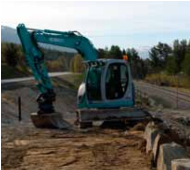
Ny og tryggare planovergang i Lesja til erstatning for fleire eldre og farlege. Foto: Njål Svingheim
