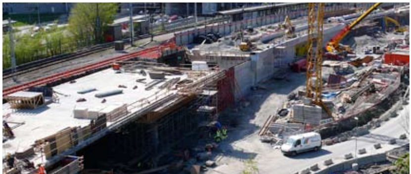
Utbygging av Lysaker stasjon. Foto: C&Z
