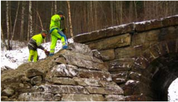
Restaurering av steinkvelvbru ved Rosten, Dovrebanen. Foto: Hans Magne Killi
