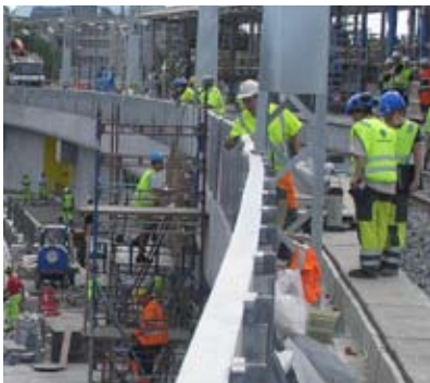
Utbygging av Lysaker stasjon. Foto: Svein Goll
