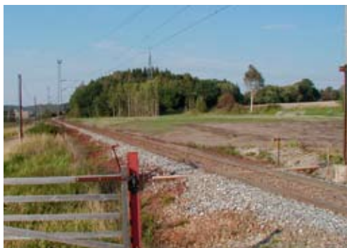
Tildekking av delvis forurenset grunn på fabrikkområdet Råde. Foto: Kjell Gulvik
