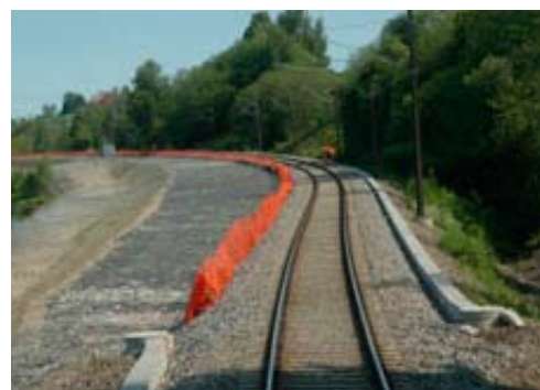
Roven kryssingsspor på Kongsvingerbanen er klart for sporlegging. Foto: Njål Svingheim
