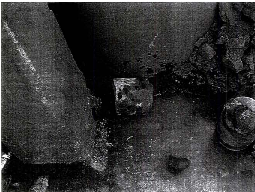
Figur 5. Mastebein, ballast og kerne.
