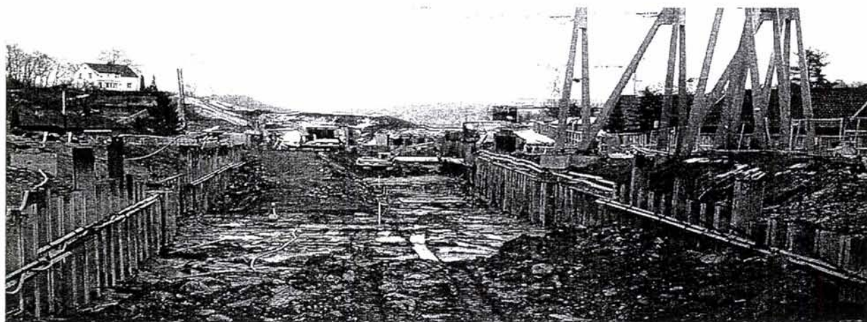
Figur 2 Oversiktsbilde K74 sett østover, klargjøring til ks-peling i fase 2
