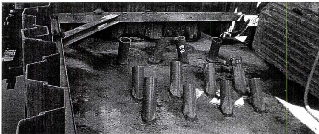
Figur 6 Maler av plastrør for nøyaktig ansett av foringsrør
