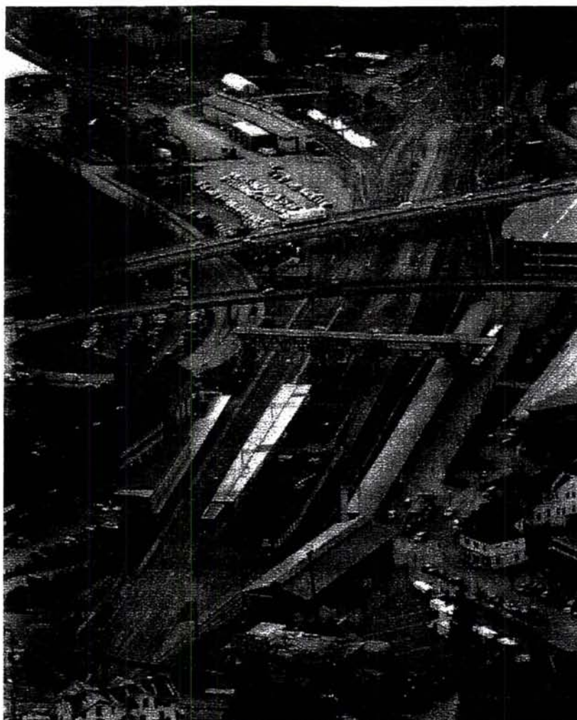
Figur 10 Oversiktsbilde av anleggsområdet og pågående arbeider i fase 10. Det går togtrafikk på begge sider av anleggsområdet.
