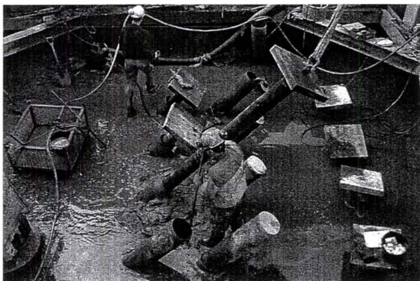
Figur 8 Setting av kjerner med helning 1:1. Mørtel kommer opp av foringsrøret
