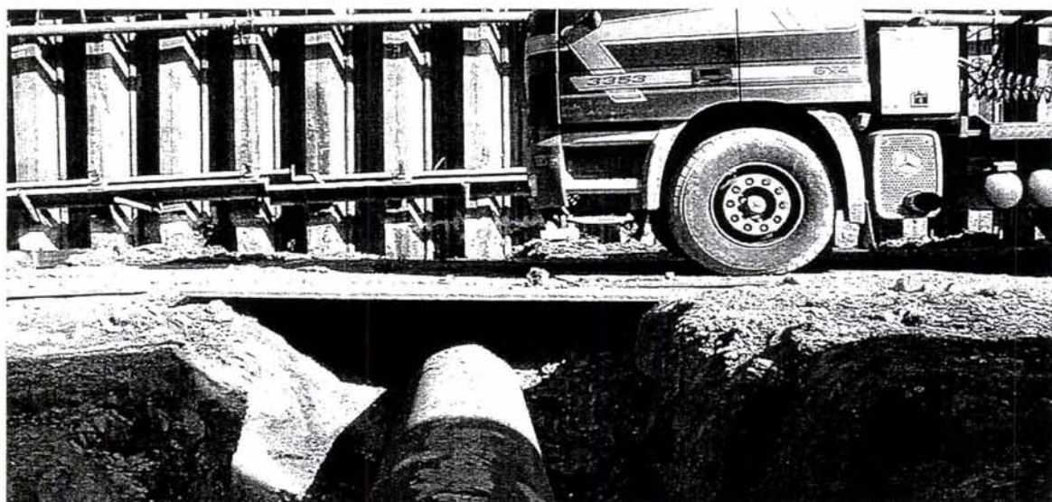
Figur 14 Kjøreplate fra ribbe til ribbe over rørstiver
