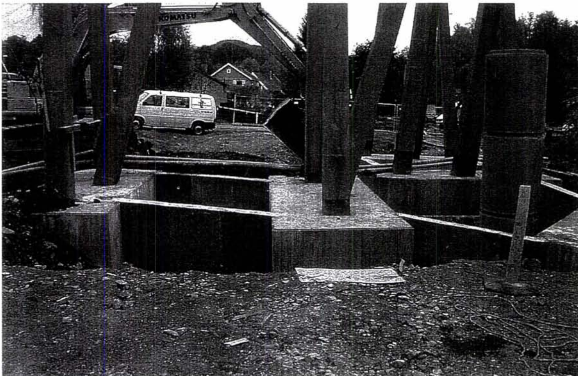
Figur 6. Avstivende skivebjelker støpt mellom fundamentene.
