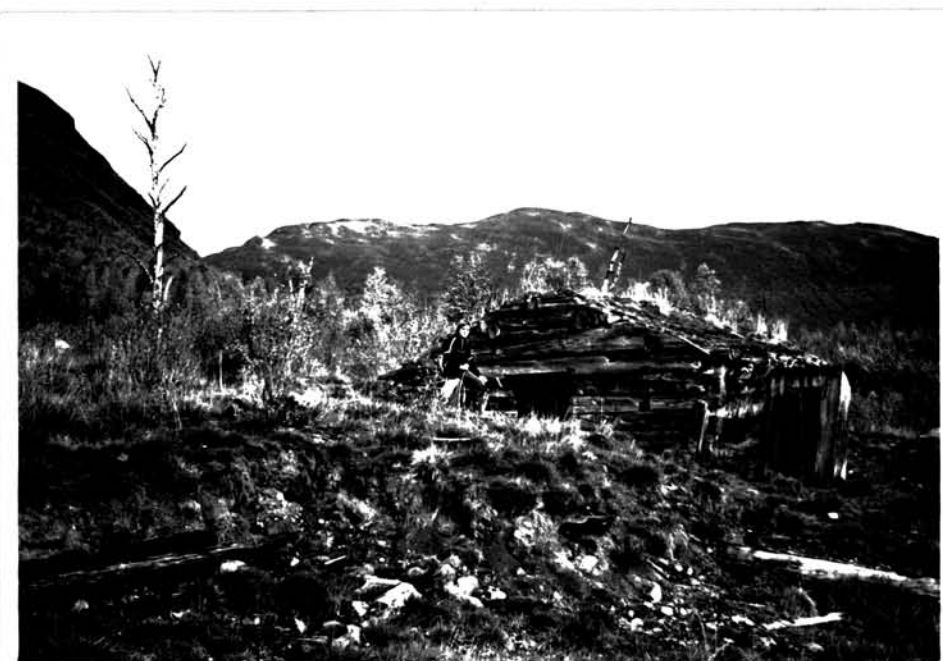
Figur 25 Ved Kabbenseter ble to hus ødelagt. Tømmerstokkene i forgrunnen stammer fra det ene.
