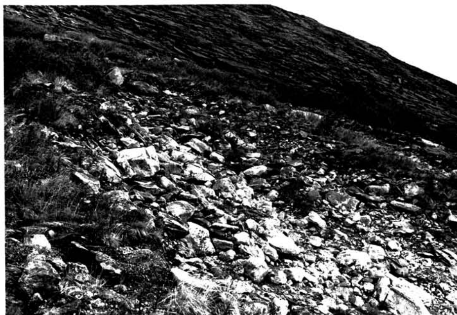
Skred 10's start i urbeltet, 50 meter vest for overstående bilde. En del urmateriale ligger igjen i renna.
