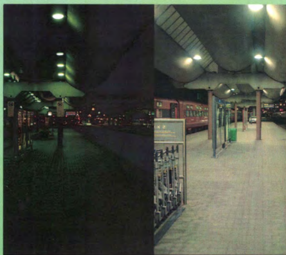
Før (til venstre) og etter utskifting av lysarmaturer på Oslo S.
